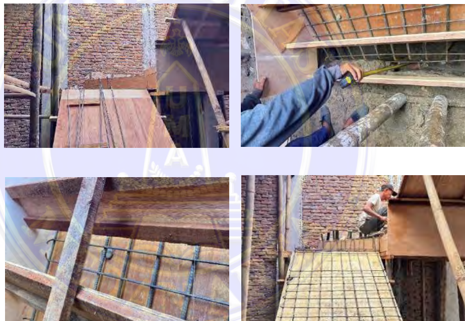
Gambar 3. 10 Perakitan pembesian tangga
