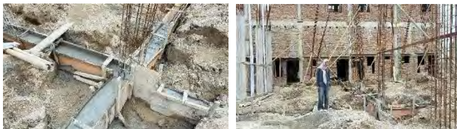
Gambar 3. 8 Pengecoran Sloof
