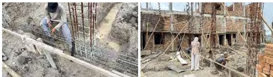
Gambar 3. 6 Perakitan tulangan sloof
