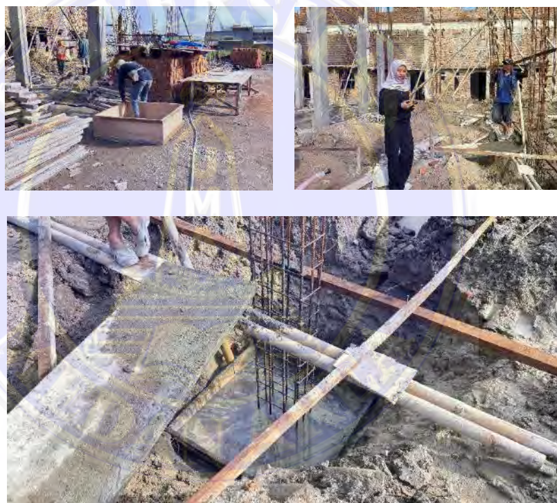
Gambar 3. 5 Pemasangan Rangka Pondasi Dan Sloof
