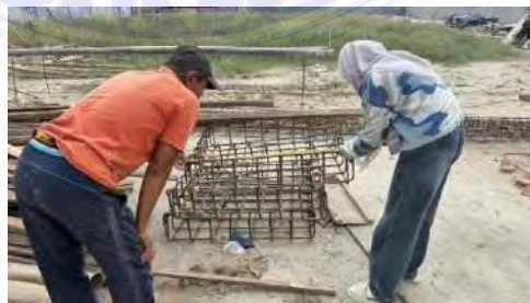
Gambar 3. 4 Pengecekan Progres Pembesian Pondasi
