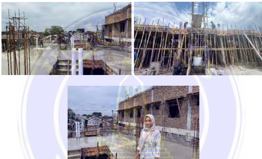
Gambar 3. 13 Pengawasan Pekerjaan Pengecoran pada Plat Lantai 2
