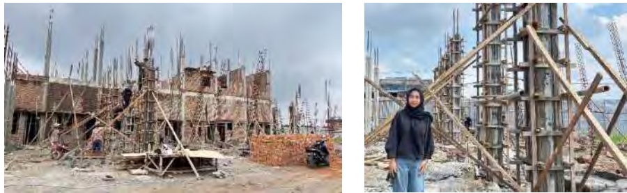
Gambar 3. 7 Pengawasan Pekerjaan Pegecoran Kolom
