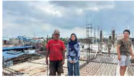
Gambar 3. 11 Pengawasan Pekerjaan Pembesian pada Plat Lantai 2
