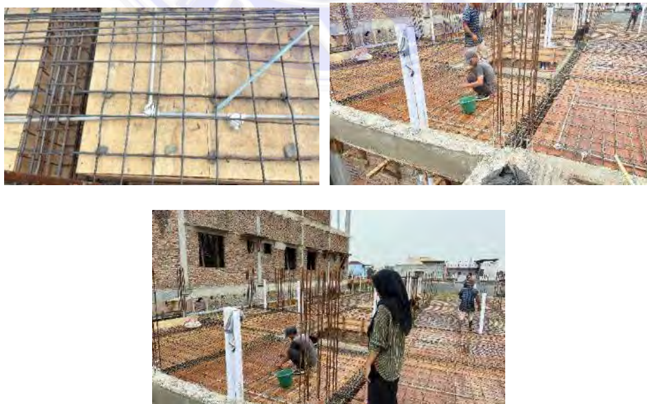
Gambar 3. 12 Pengawasan Pekerjaan Pemasangan Instalasi Listrik pada Plat Lantai 2
