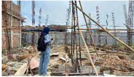
Gambar 3. 5 Pengawasan Pengerjaan Pembuatan Bekisting Kolom
