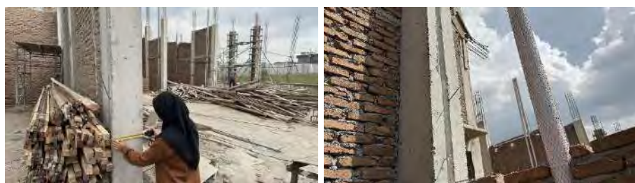
Gambar 3. 9 Pengecekan Ukuran Kolom
