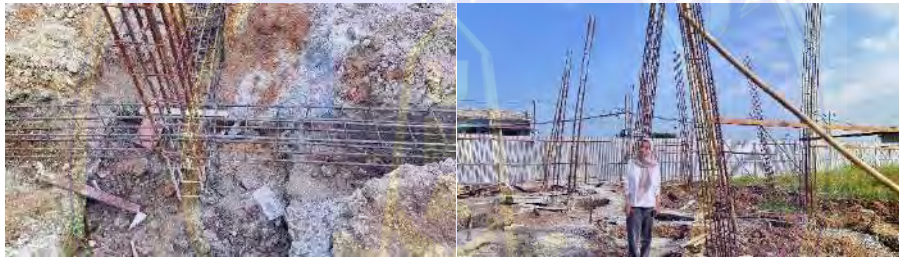
Gambar 3. 4 Pengawasan Pengerjaan Penyambungan Kolom
