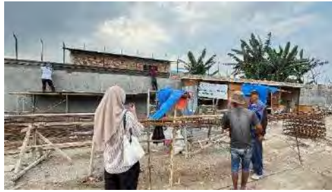
Gambar 3. 3 Pengecekan Progres Pembesian Kolom
