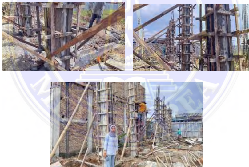
Gambar 3. 6 Pengawasan Pengerjaan Pemasangan Bekisting
