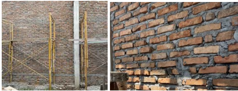
Gambar 3. 9 Pengawasan penyelesaian sisa pasangan bata
