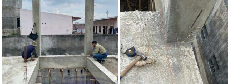
Gambar 3. 6 Pengawasan pengukuran dan penentuan as dinding
