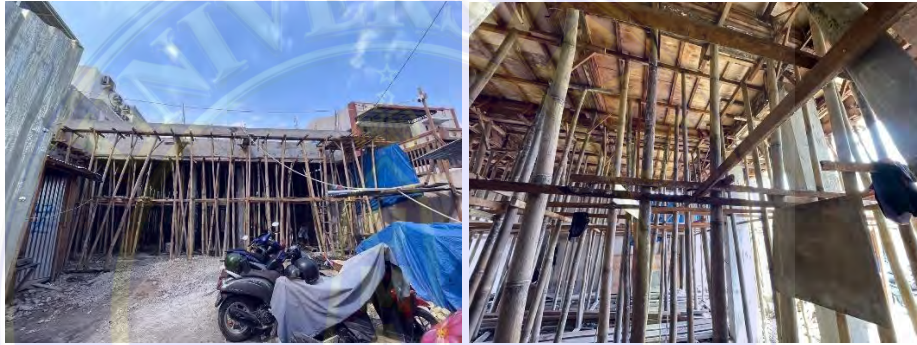
Gambar 3. 2 Pengawasan bekisting
