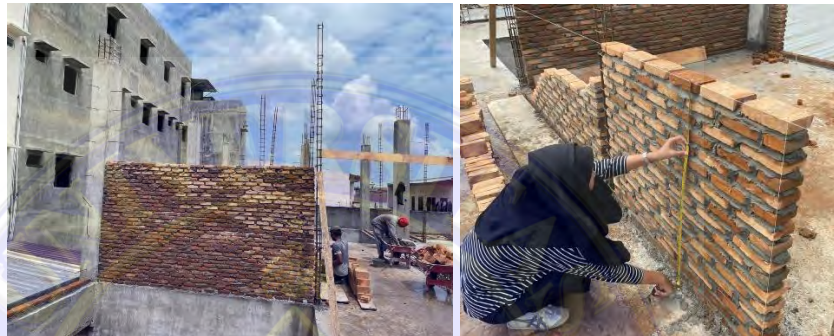
Gambar 3. 8 Pengawasan lanjutan pemasangan bata
