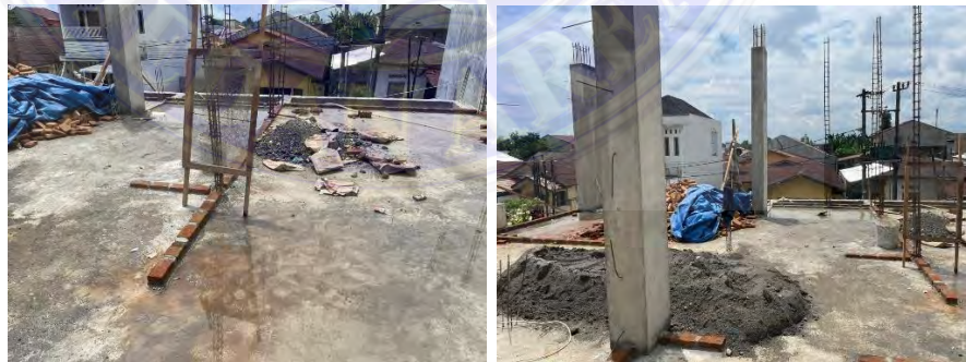
Gambar 3. 7 pemasangan bata tahap awal
