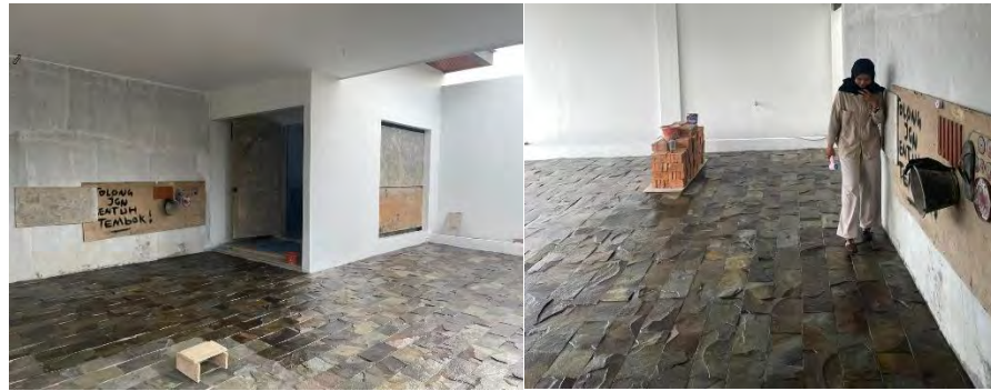
Gambar 3. 3 Pengawasan pekerjaan coating
