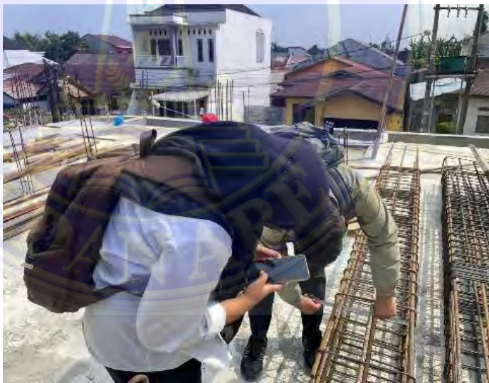
Gambar 3. 3 Pengecekan ukuran tulangan kolom
