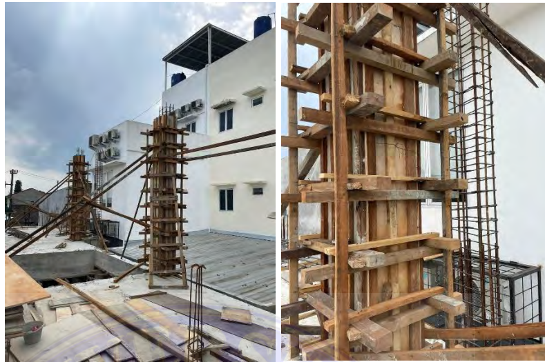
Gambar 3. 8 Pengawasan pemasangan bekisting kolom
