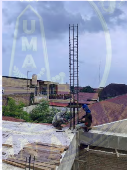
Gambar 3. 7 Pengawasan pemasangan sambungan kolom
