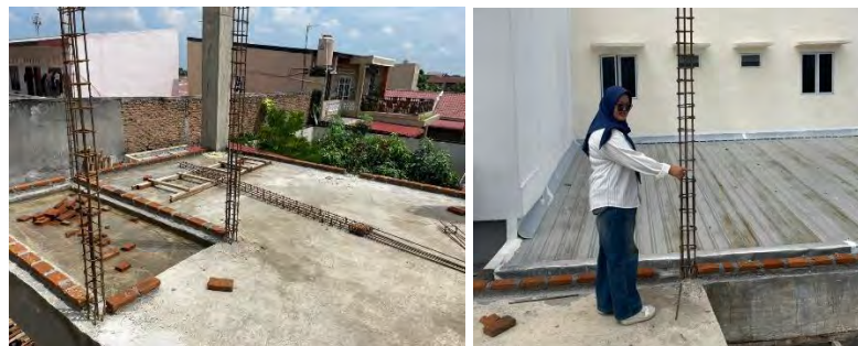
Gambar 3. 11 Pengawasan pemasangan rangka kolom praktis
