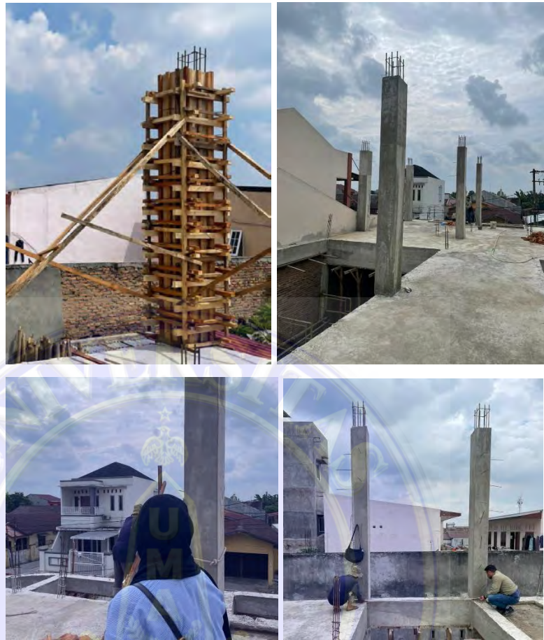
Gambar 3. 10 Pengawasan pelepasan bekisting kolom
