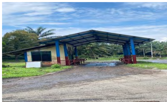
Gambar 3. 2 Jembatan Timbang PKS Dolok Ilir
