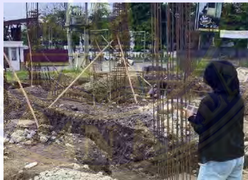
Gambar 3. 17. Dokumentasi Penulis Pada Saat Melihat Besi Sloof yang Sudah Terpasang
