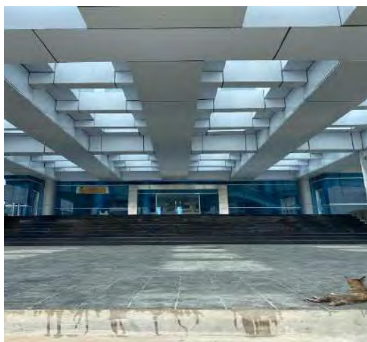
Gambar 3. 1. Foto Lokasi Proyek KP 2 Achmad Tahir Hotel
