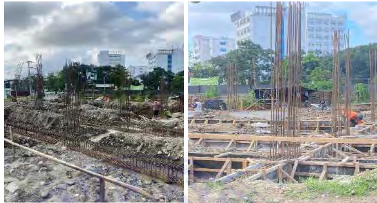
Gambar 3. 16. Pemasangan Besi dan Bekisting Sloof
