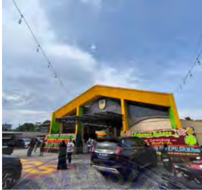
Gambar 2. 13 Durian House (Bangunan yang telah selesai)
