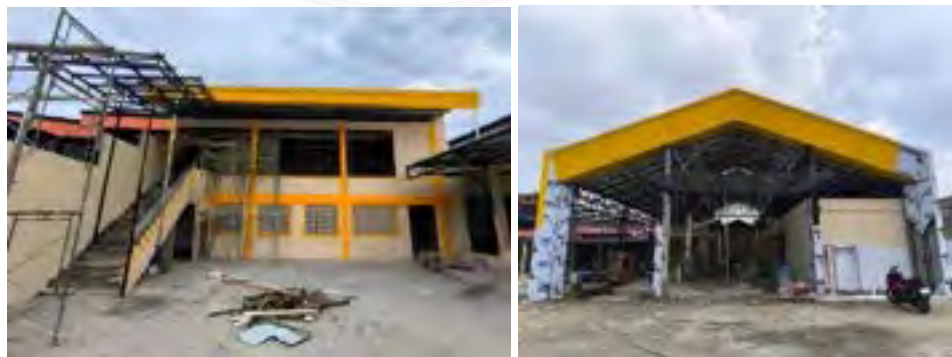
Gambar 2. 12 Durian House (Proses Pembangunan)
