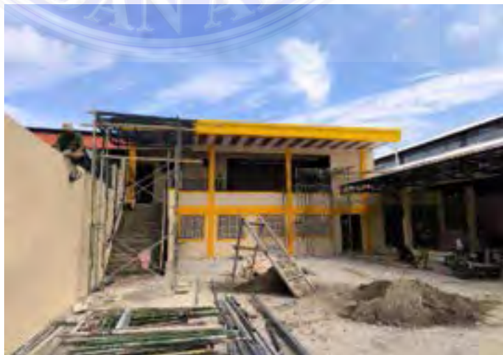
Gambar 3. 65 Kondisi Lapangan (Rumah Owner & Gudang)
