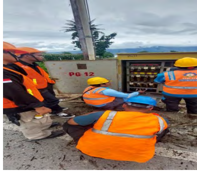
Gambar 3. 3 Mengukur pada panel PHB
