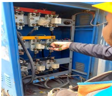
Gambar 3. 12 Memasukkan NT/NH fuse
