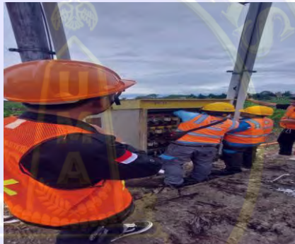
Gambar 3. 4 Membuka NT/NH fuse
