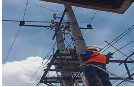
Gambar 3. 6 Pengukuran kumparan trafo daya
