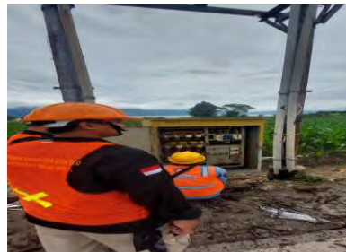
Gambar 3. 2 Membuka panel hubung bagi
