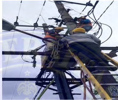
Gambar 3. 7 Pembersihan bushing TR dan TM
