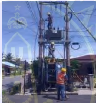
Gambar 3. 10 Pemasangan trafo
