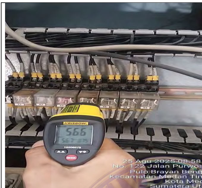
Gambar 5. Melakukan pengecek pada panel utama dari trafo, mengecek suhu dengan menggunakan alat Thermometer .
