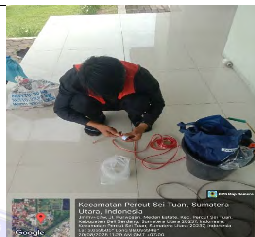
Gambar 2. Melakukan Perbaikan bola lampu yang sudah rusak
