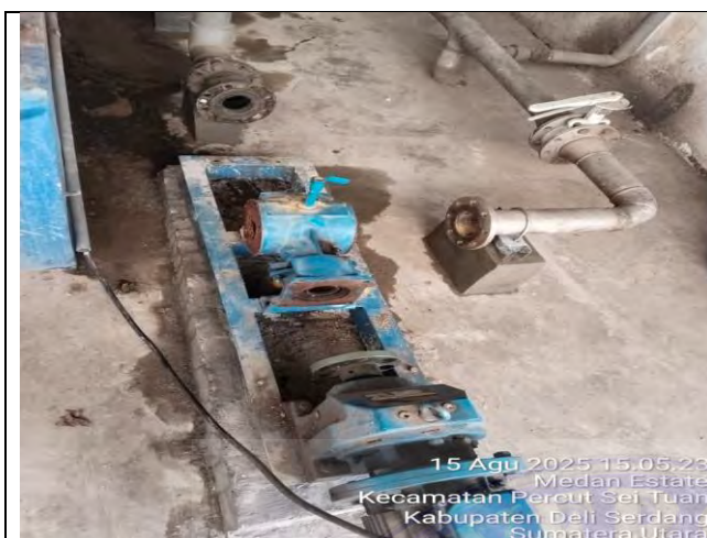
Gambar 1. Mengamati perbaikan pada pompa Motor Slurry Pump
