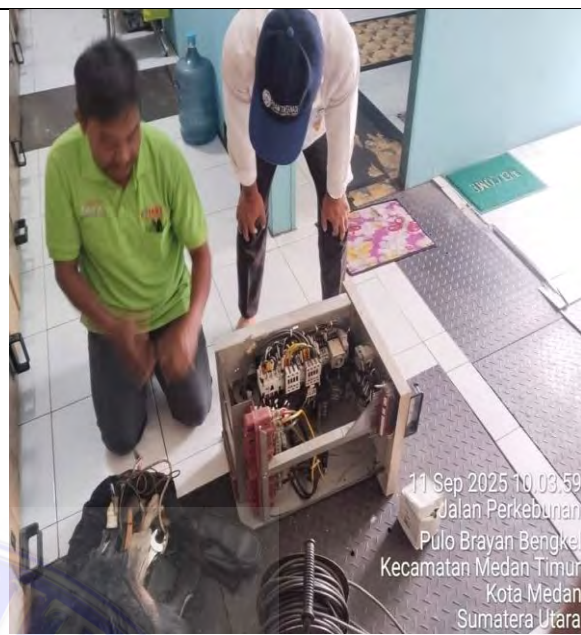
Gambar 6. Memperbaiki panel Aerator no. 4 untuk mengganti kotaktor pada panel Aerator no. 4 Yang sudah terbakar.
