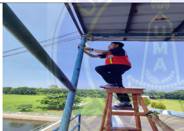
Gambar 3. Memasang bola lampu di area IPLT slurryy pump
