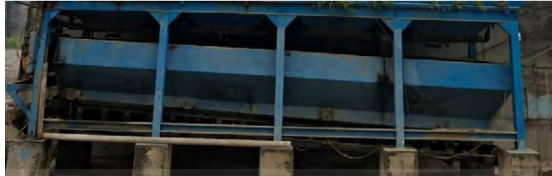
Gambar 3.5. Timbangan Agregat (Dokumentasi,2025)
