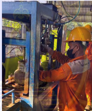
Gambar 3. 4 Stasiun Leak Test Awal
