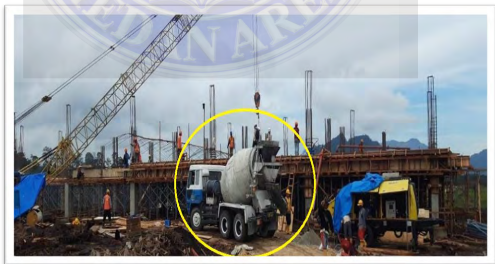
Gambar 3. 14 Concrete Mixer (Sumber : Dokumentasi Lapangan)
