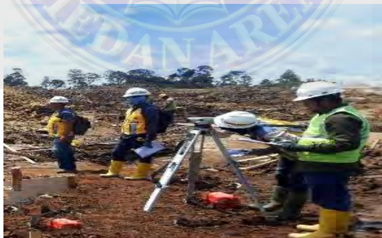
Gambar 3. 9 Waterpass (Sumber : Dokumentasi Lapangan)
