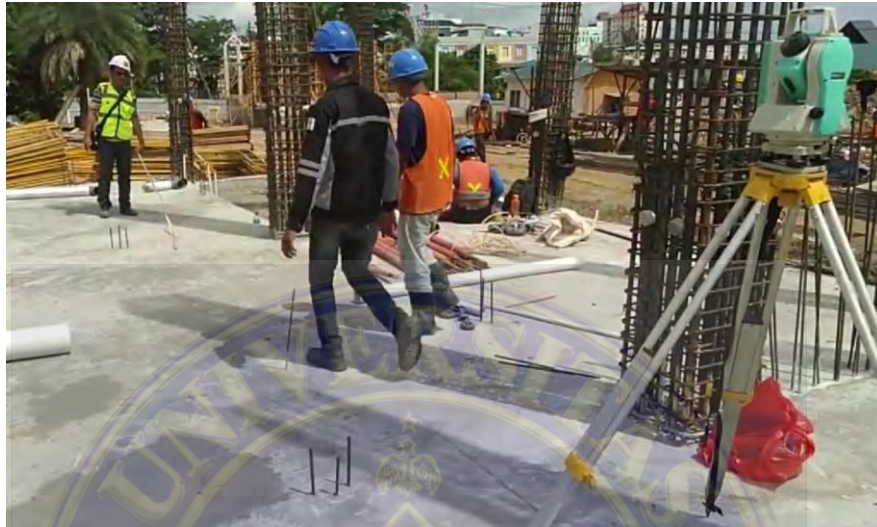
Gambar 4. 2 Penentuan As Kolom (Sumber : Dokumentasi Lapangan)
