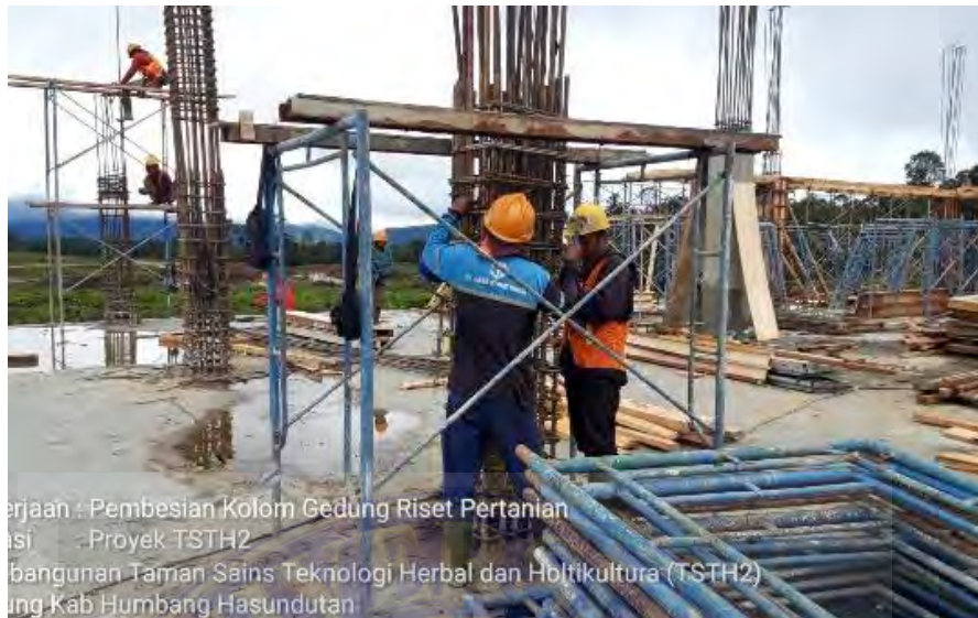
Gambar 4. 5 Pemasangan Tulangan Kolom (Sumber : Dokumentasi Lapangan)
