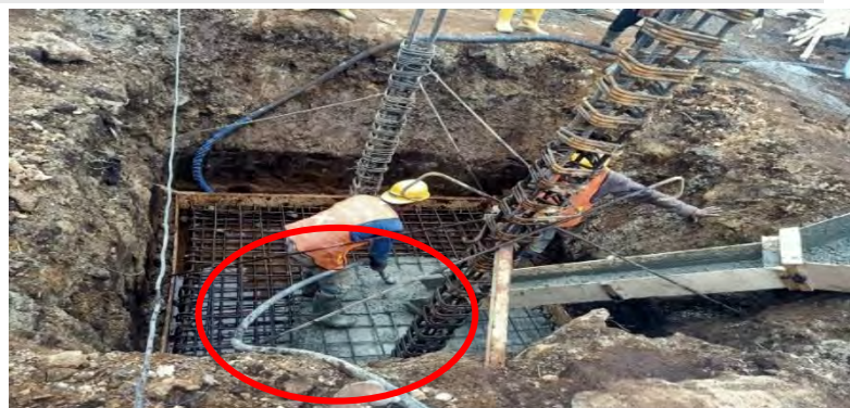
Gambar 3. 13 Vibrator (Sumber : Dokumentasi Lapangan)
