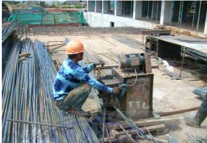
Gambar 4. 4 Kegiatan Pemotongan Tulangan (Sumber : Dokumentasi Lapangan)
