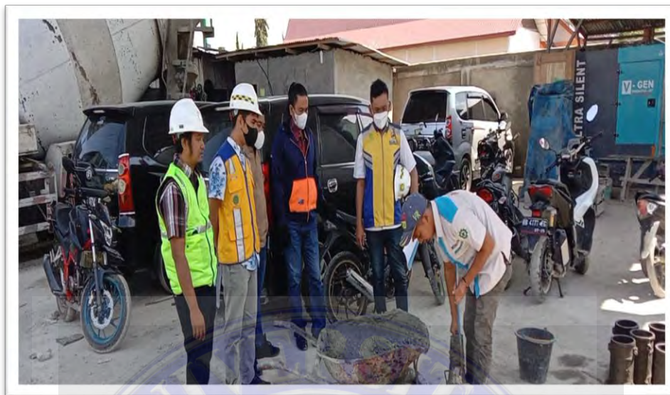
Gambar 4. 9 Uji Slump (Sumber : Dokumentasi Lapangan)
