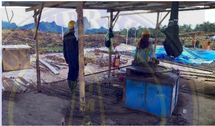
Gambar 3. 7 Bar Bender (Sumber : Dokumentasi Lapangan)
