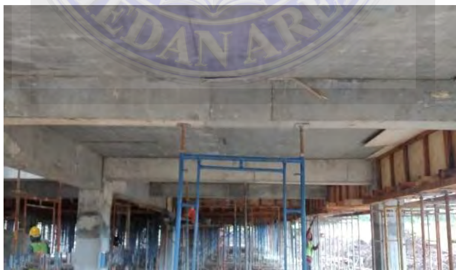
Gambar 4. 10 Pembongkaran Bekisting Kolom (Sumber : Dokumentasi Lapangan)
