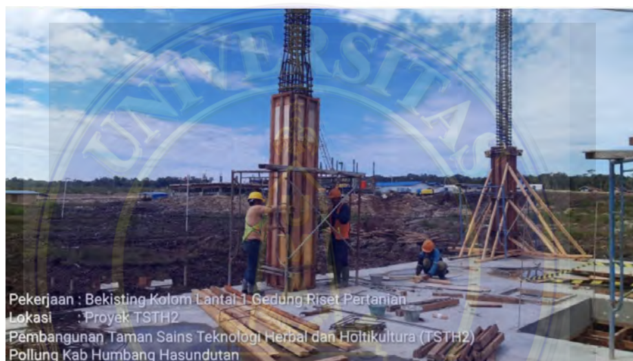
Gambar 4. 6 Pemasangan Bekisting Kolom (Sumber : Dokumentasi Lapangan)
