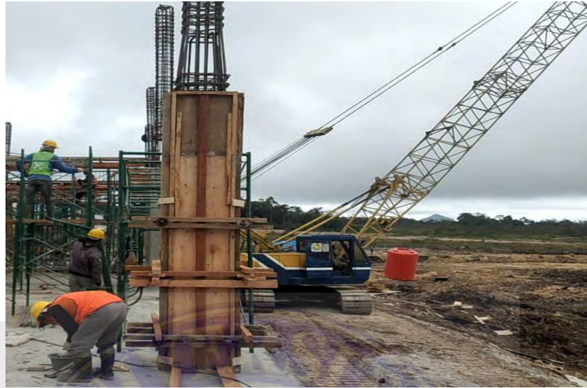
Gambar 3. 12 Bekisting (Sumber : Dokumentasi Lapangan)
