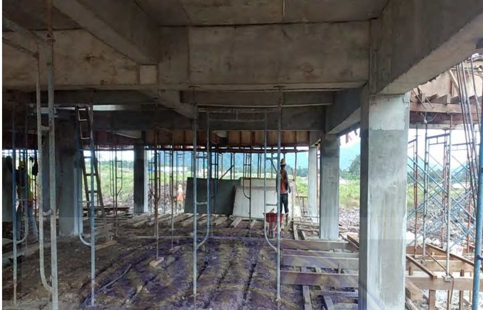
Gambar 4. 11 Sesudah Pembongkaran Bekisting Kolom (Sumber : Dokumentasi Lapangan)
