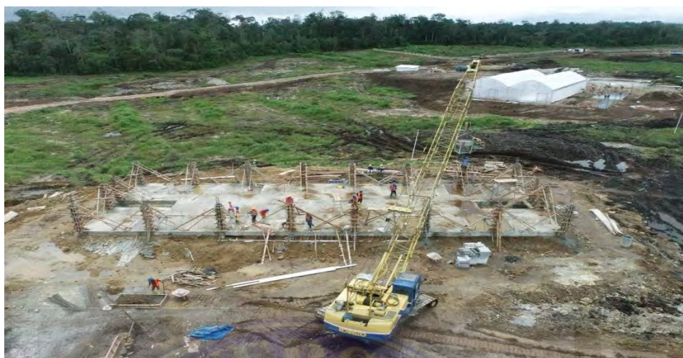
Gambar 3. 8 Crawler Crane (Sumber : Dokumentasi Lapangan)
