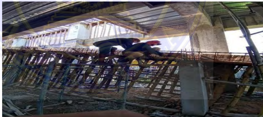
Gambar 4. 5 Pengecoran balok ramp Dokumentasi proyek, 2025)
