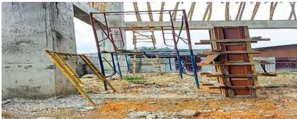
Gambar 3. 16 Kolom ramp (Dokumentasi proyek, 2025)
