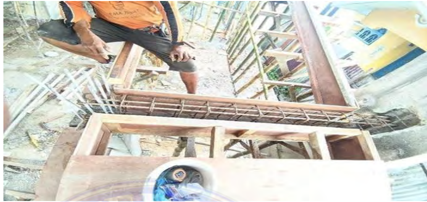
Gambar 4. 4 Pemasangan bekisting dan pembesian balok (Dokumentasi proyek, 2025)
