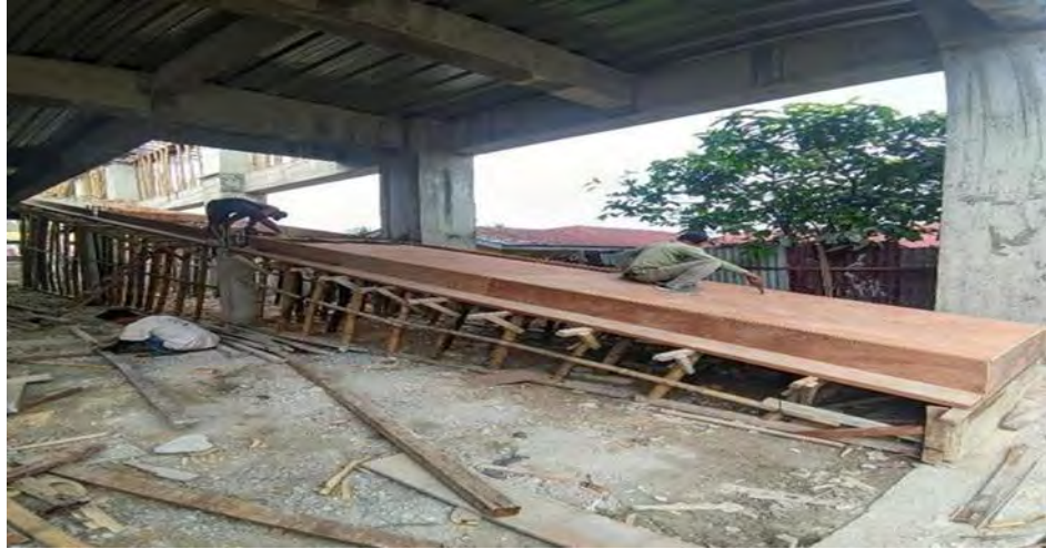
Gambar 3. 18 Pemasangan multipeks untuk lantai dasar pengecoran (Dokumentasi proyek, 2025)
