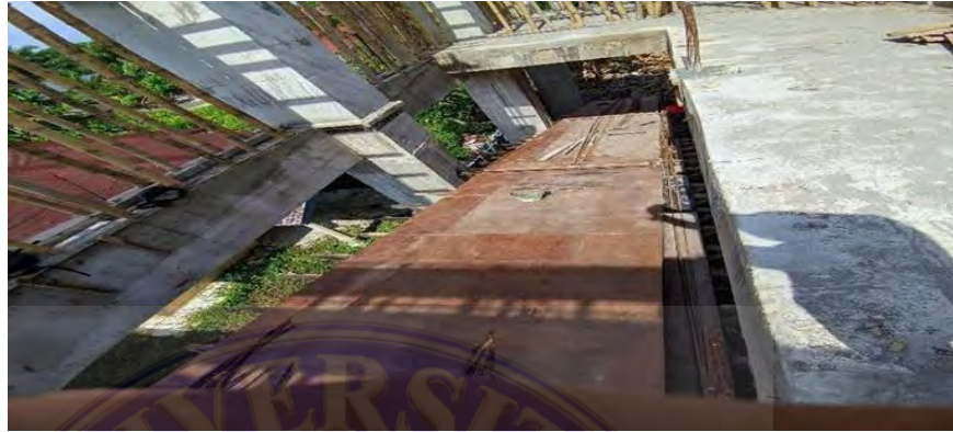
Gambar 4. 8 Persiapan pengecoran ramp (Dokumentasi proyek, 2025)
