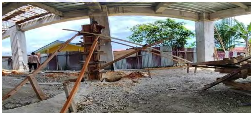
Gambar 4. 2 Pengecoran kolom ramp (Dokumentasi proyek, 2025)
