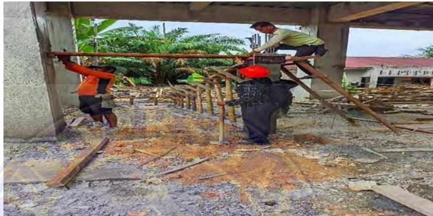
Gambar 4. 3 Pengukuran tinggi kolom ramp (Dokumentasi proyek, 2025)
