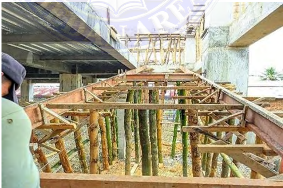
Gambar 3. 17 Pemasangan beskisting (Dokumentasi proyek, 2025)
