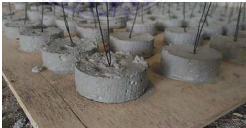
Gambar 3. 13 Tahu beton (Dokumentasi proyek, 2025)
