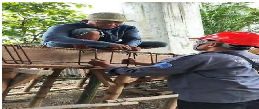
Gambar 4. 7 Pembesian pelat ramp (Dokumentasi proyek, 2025)
