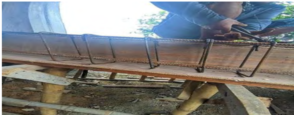
Gambar 3. 19 Penulangan (Dokumentasi proyek, 2025)
