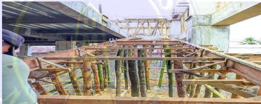
Gambar 4. 6 Pemasangan bekisting plat ramp (Dokumentasi proyek, 2025)
