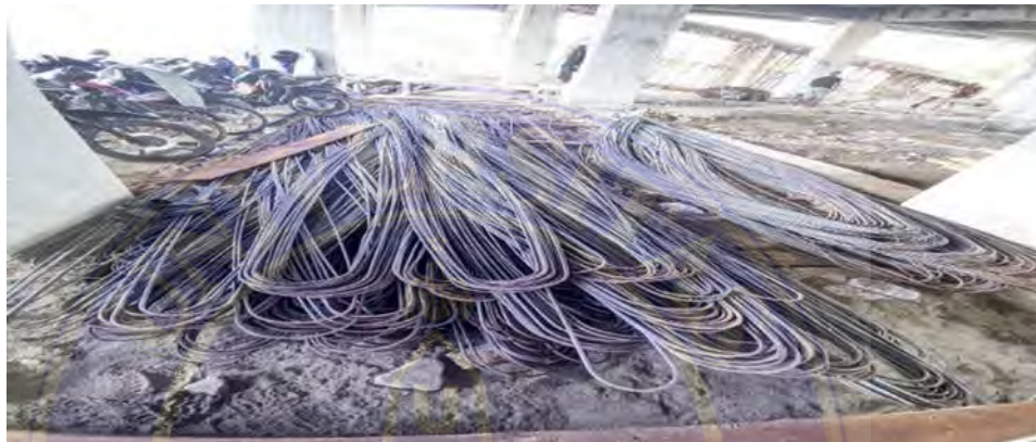
Gambar 3. 12 Besi (Dokumentasi proyek, 2025)
