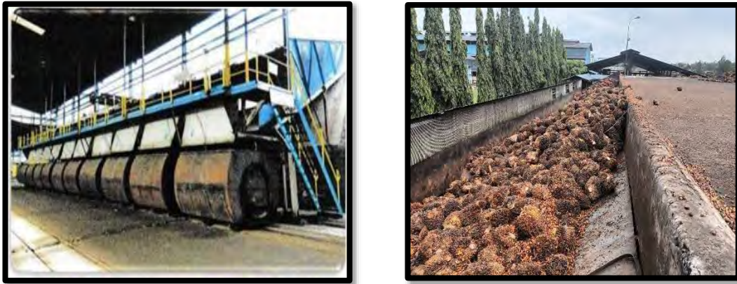
Gambar 3. 3 Lading Ramp Line I Dan Line II
