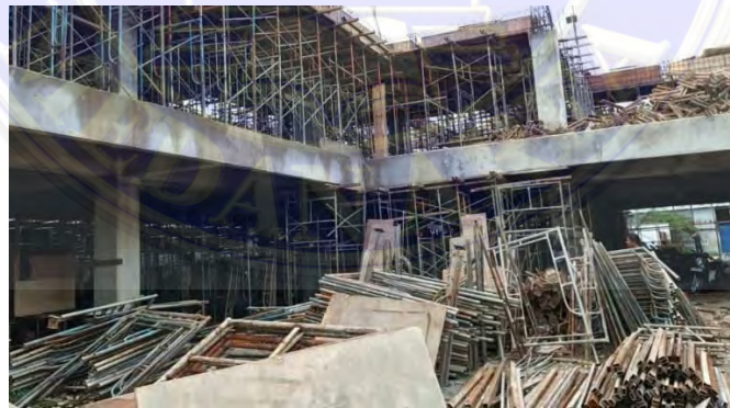
Gambar 3.5 Scaffolding (Dokumentasi Proyek, 2026)
