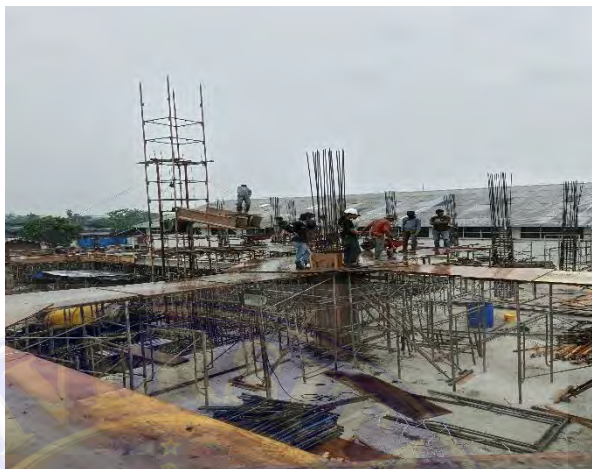
Gambar 3. 17 Pelaksanaan Pengecoran (Dokumentasi Proyek, 2026)
