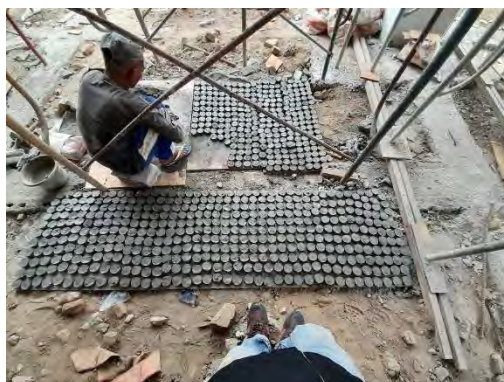
Gambar 3.13 Beton Decking (Dokumentasi Proyek, 2026)
