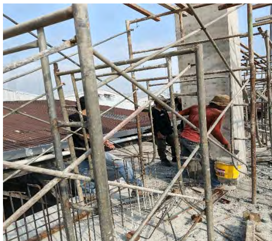
Gambar 3.18 Pembongkaran Bekisting (Dokumentasi Proyek, 2026)
