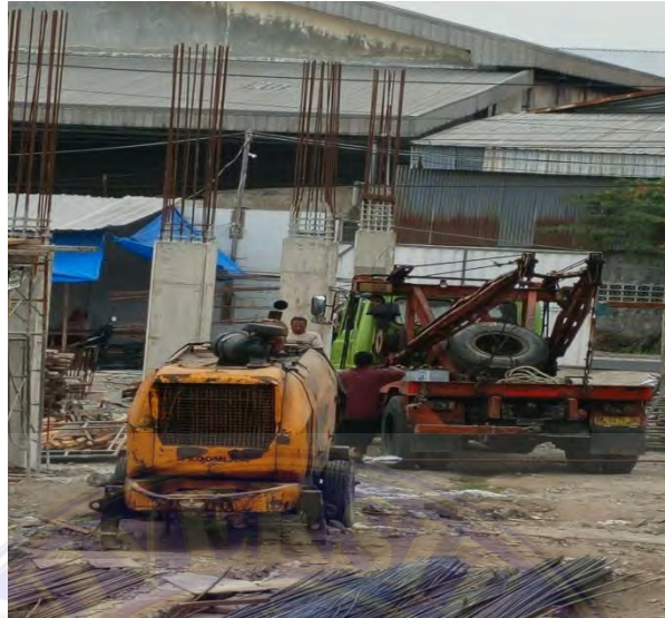
Gambar 3.4 Concrete Pump (Dokumentasi Proyek, 2026)
