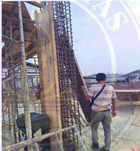
Gambar 3. 16 Pemasangan Bekisting (Dokumentasi Proyek, 2026)
