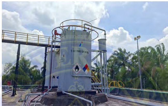
Gambar 3.34 (FWKO)Sistem Pengelolaan Air Terproduksi dan Limbah Cair.
