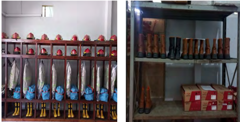
Gambar 4. 7 Ruang penyimpanan APD Dan SCBA ( Self Contained Breathing Apparatus ).
