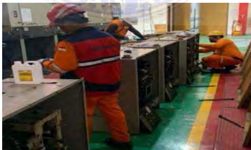
Gambar 2. 2. Pembersihan Peralatan Distribusi
