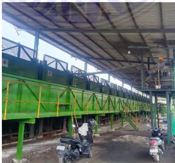
Gambar 3. 4 Stasiun Loading Ramp
