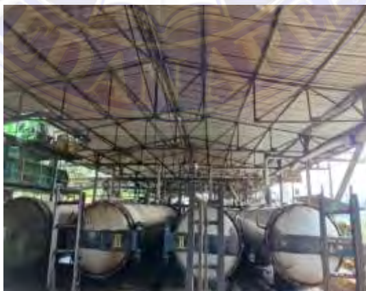
Gambar 3.5 Stasiun Perebusan (Sterilizer)
