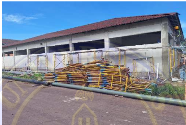
Gambar 3.10 Scaffolding (Dokumentasi Proyek, 2026)
