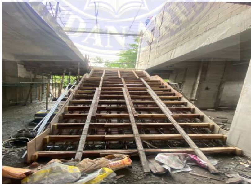
Gambar 3.32 Pemasangan Bekisting Tangga (Dokumentasi Proyek, 2026)
