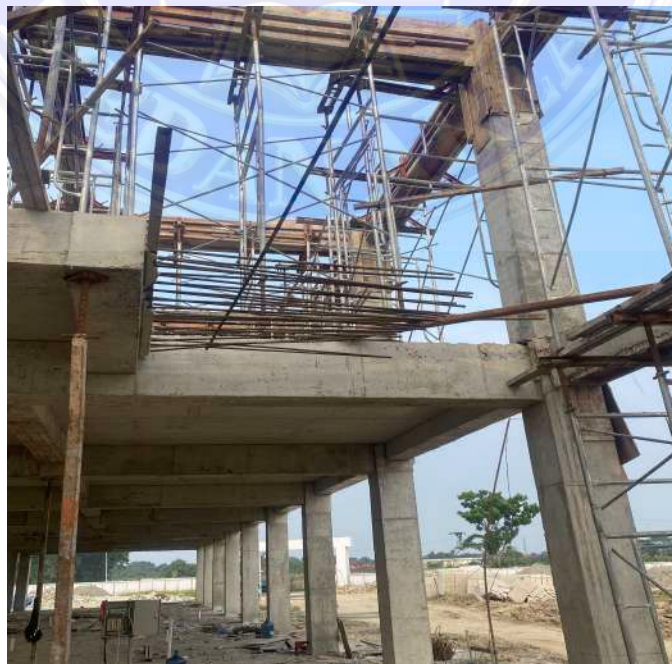
Gambar 3.31 Pemasangan Tulangan Tangga (Dokumentasi Proyek, 2026)
