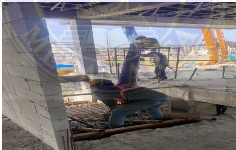
Gambar 3.33 Pelaksanaan Pengecoran Tangga (Dokumentasi Proyek, 2026)
