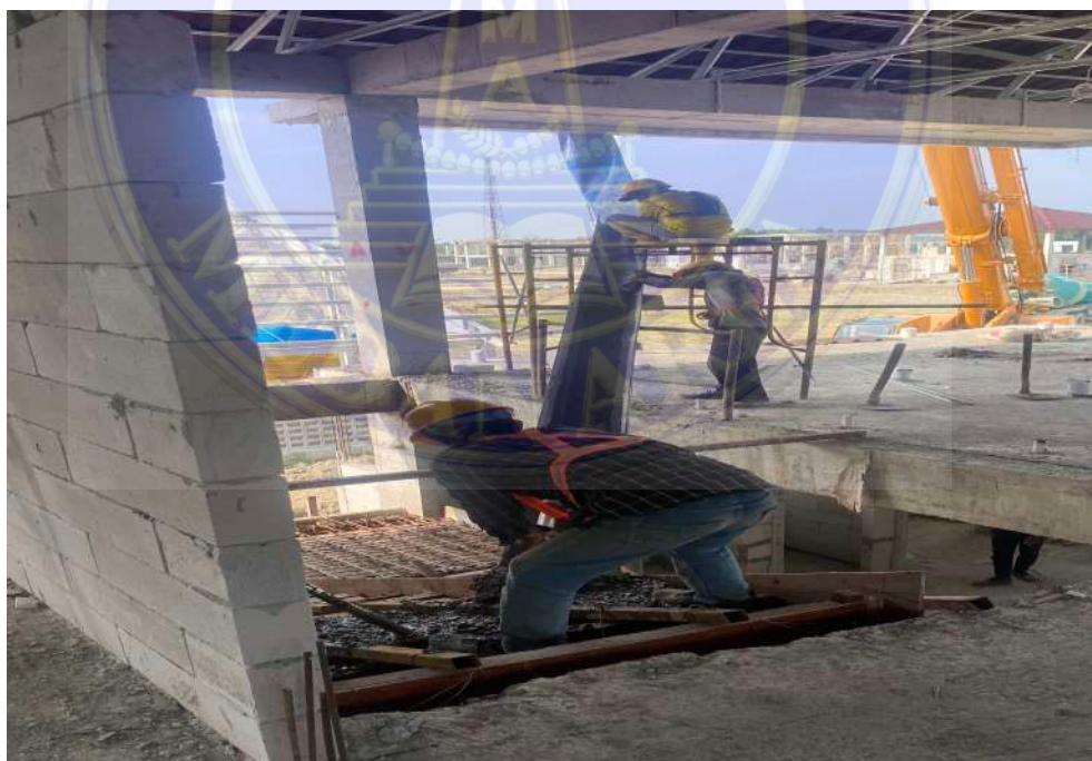
Gambar 4 Pengecoran Tangga
