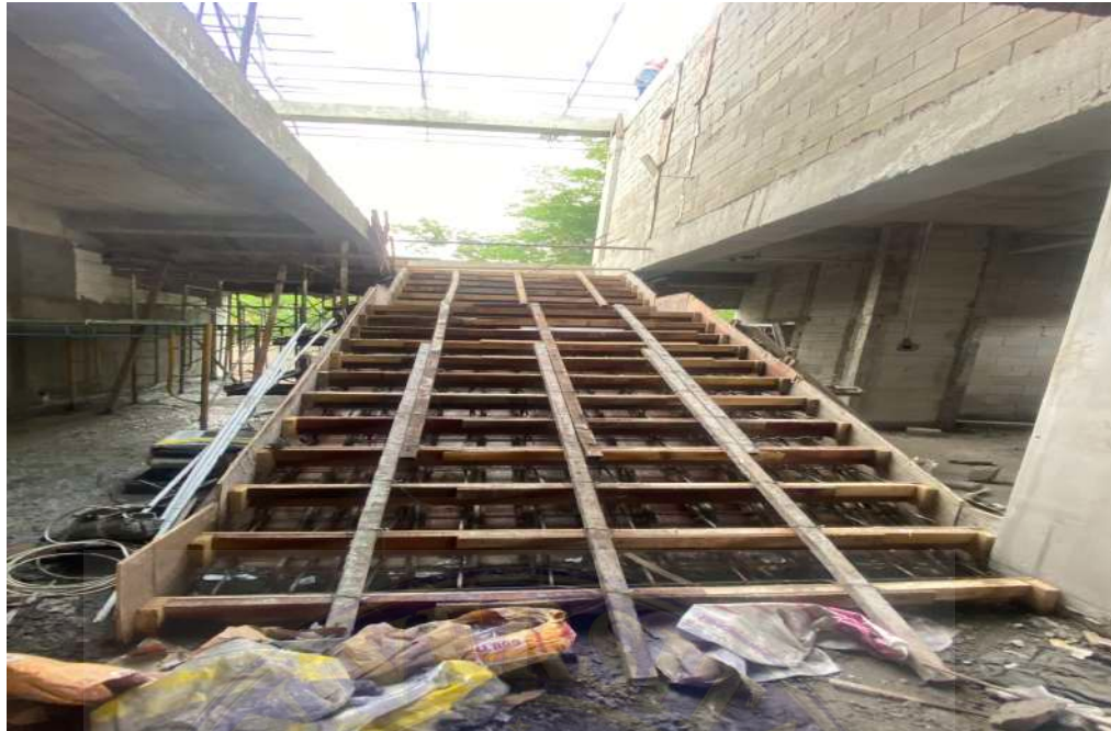
Gambar 3 Pemasangan bekisting Tangga
