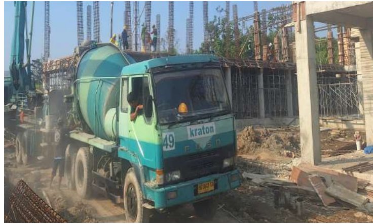
Gambar 3.2 Truck Mixer (Dokumentasi Proyek, 2026)
