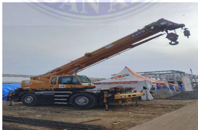
Gambar 3.5 Mobile Crane (Dokumentasi Proyek, 2026)
