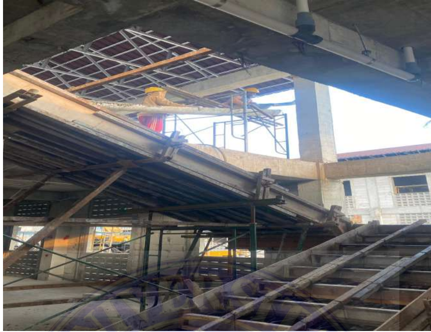
Gambar 3.34 Pelaksanaan Pengecoran Tangga (Dokumentasi Proyek, 2026)
