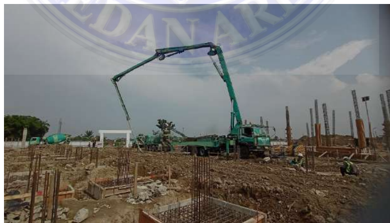
Gambar 3.3 Concrete Pump (Dokumentasi Proyek, 2026)
