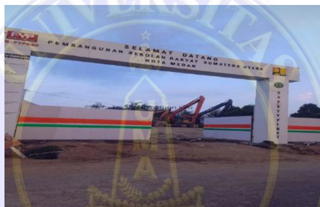
Gambar 2.3 Lokasi Proyek (Dokumentasi Proyek, 2026)
