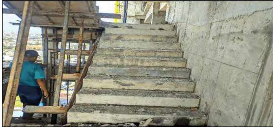
Gambar 3.35 Pembongkaran Bekisting Tangga (Dokumentasi Proyek, 2026)
