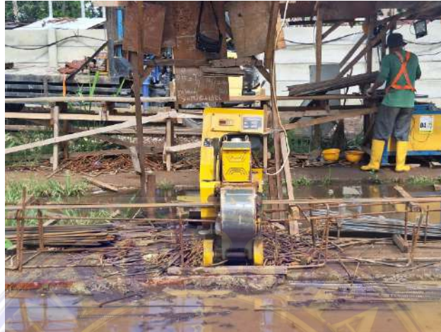
Gambar 3.6 Bar Cutter (Dokumentasi Proyek, 2026)
