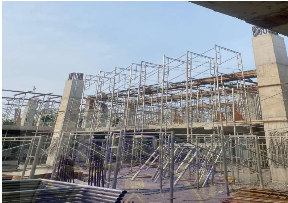
Gambar 1 Pemasangan Scaffolding
