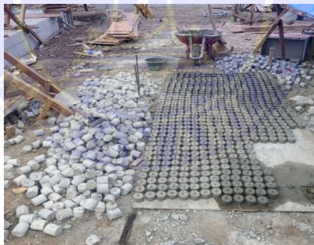
Gambar 3.30 Beton Decking (Dokumentasi Proyek, 2026)
