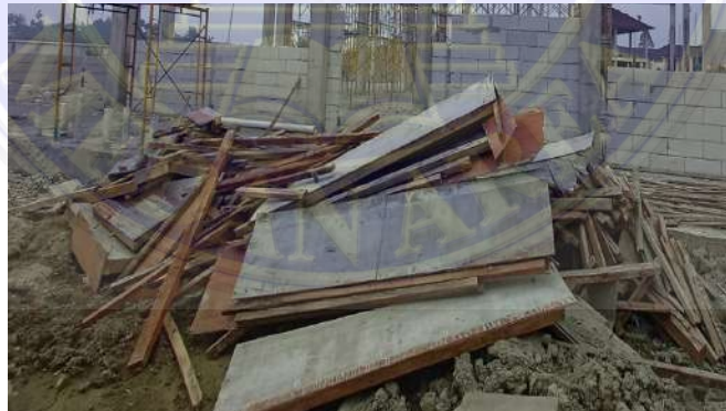
Gambar 3.20 Kayu (Dokumentasi Proyek, 2026)
