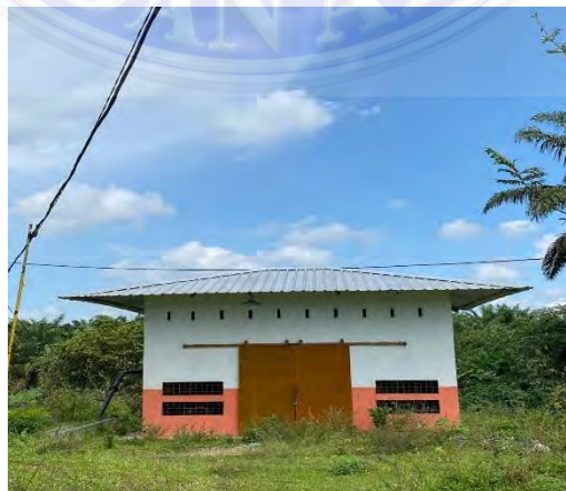
Gambar 3. 58 pompa air dan sumber air
