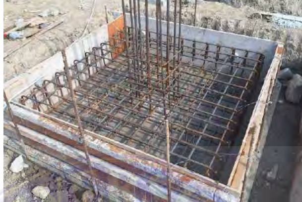
Gambar 3.2 Pembesian Pile Cap (Dokumentasi Proyek, 2025)
