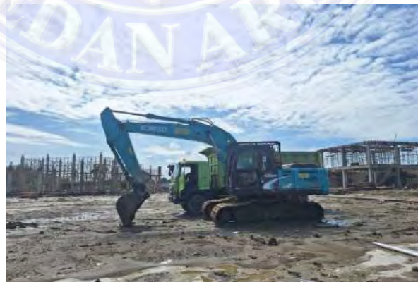
Gambar 3.3 Excavator (Dokumentasi Proyek, 2026)
