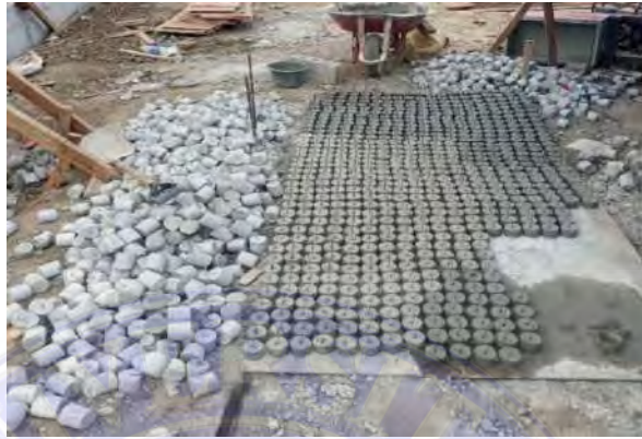
Gambar 3.18 Beton Decking (Dokumentasi Proyek, 2025)
