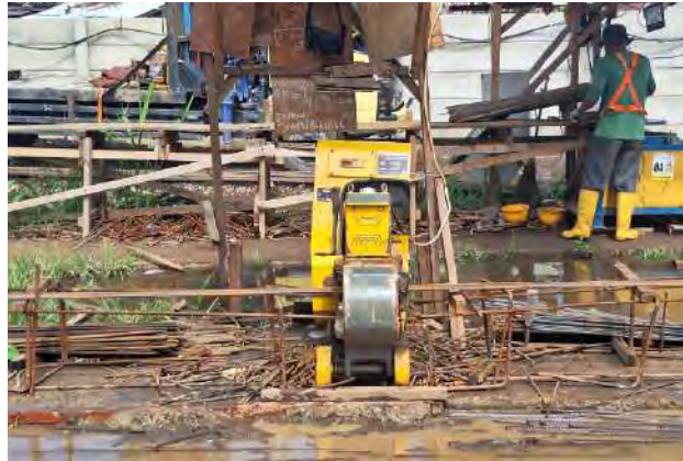
Gambar 3.7 Bar Cutter (Dokumentasi Proyek, 2026)
