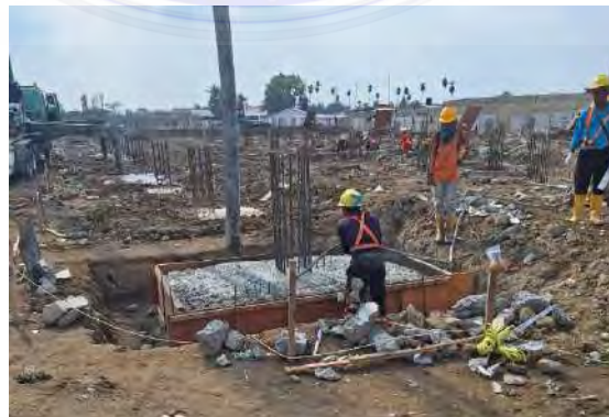
Gambar 3.21 Pengecoran Pile Cap (Dokumentasi Proyek, 2026)
