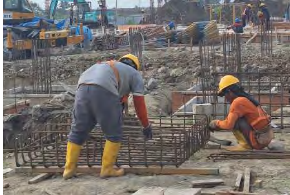
Gambar 3.20 Pembesian Pile Cap (Dokumentasi Proyek, 2026)
