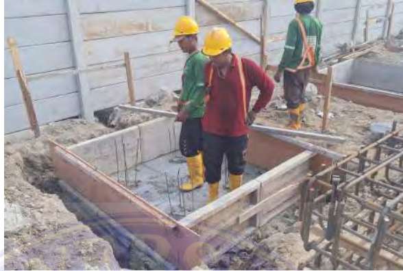
Gambar 3.19 Pemasangan Bekisting (Dokumentasi Proyek, 2026)
