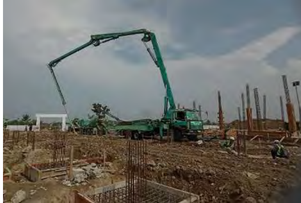
Gambar 3.5 Concrete Pump (Dokumentasi Proyek, 2026)
