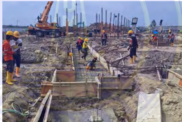
Gambar 3.1 Pemasangan Bekisting (Dokumentasi Proyek, 2026)
