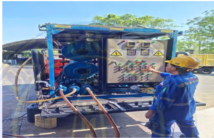
Gambar 4. 3 Pengoperasian Mesin Filter Minyak Trafo
