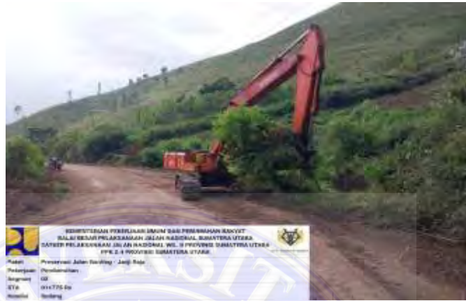
Gambar 4.2 Pekerjaan penggalian tebing (Dokumentasi Proyek, 2026)
