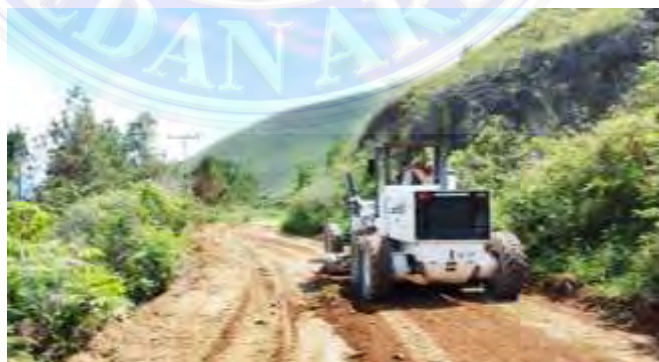
Gambar 4.1 Pekerjaan Penyiapan Badan Jalan (Dokumentasi Proyek, 2026)
