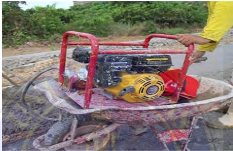
Gambar 3.6 Vibrator (Dokumentasi Proyek, 2026)
