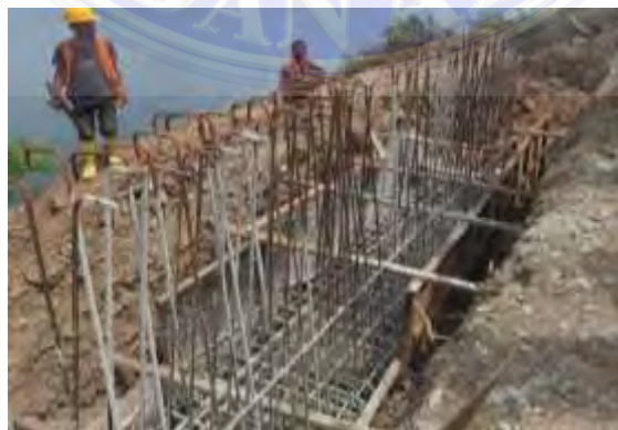
Gambar 3.9 Bekisting (Dokumentasi Proyek, 2026)
