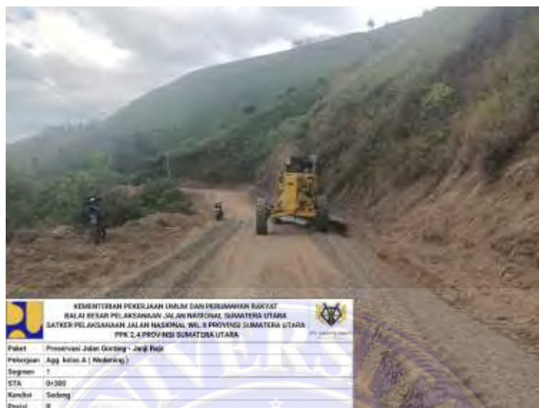
Gambar 4.4 Penghamparan base untuk pelebaran (Dokumentasi Proyek, 2026)
