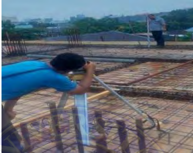
Gambar 4.5 Gambar Proses Penentuan Titik Elevasi Balok
