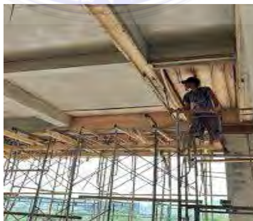
Gambar 3.34 Pembongkaran Bekisting Balok
