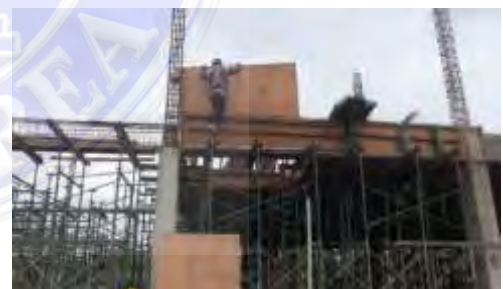
Gambar 4.7 Gambar Proses Pemasangan Bekisting
