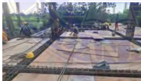
Gambar 4.7 Gambar Proses Pemasangan Bekisting
