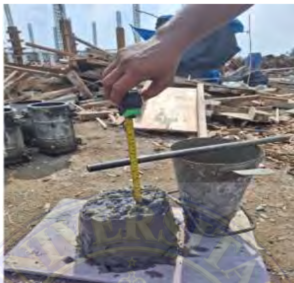
Test slump pengecoran Balok
