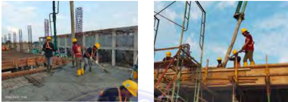
Gambar 4.8 Gambar Proses Pengoceran Balok
