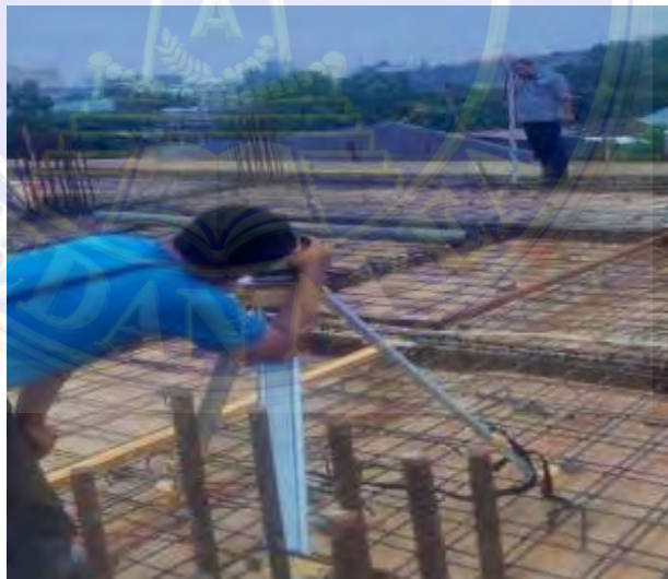
Gambar 3.31 Penentuan Elevasi Balok
