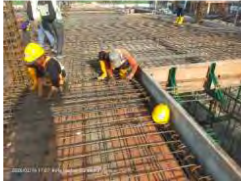
Gambar 4.6 Gambar Proses Penulangan Balok
