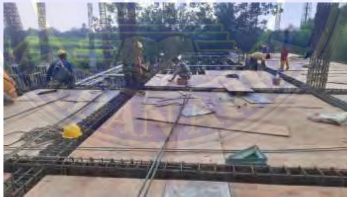
Gambar 3.31 Pemasangan Bekesting Balok
