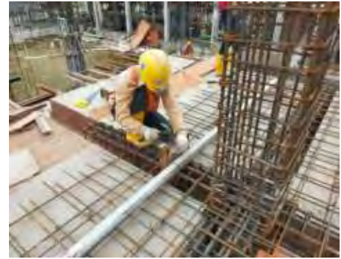
Gambar 4.6 Gambar Proses Penulangan Balok
