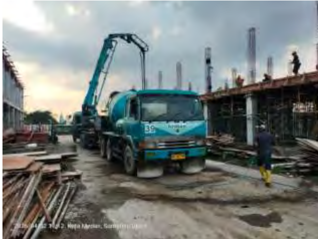
Gambar 3.33 Pengecoran Balok
