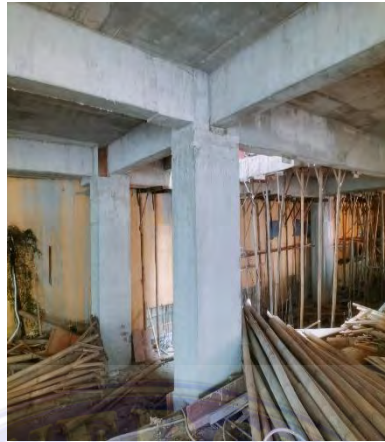
Gambar 3.21 Pembongkaran bekisting
