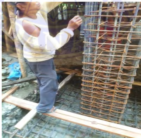
Gambar 3.17 Perakitan tulangan kolom
