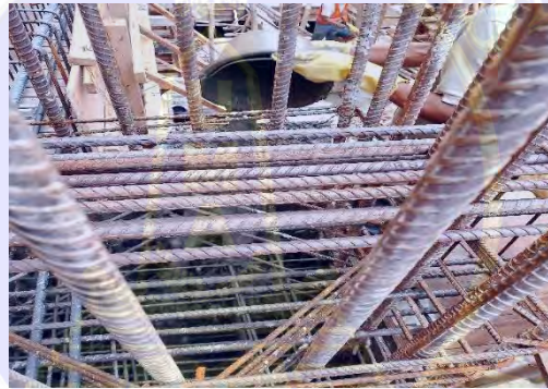
Gambar 3. 20 Proses Pengecoran Kolom
