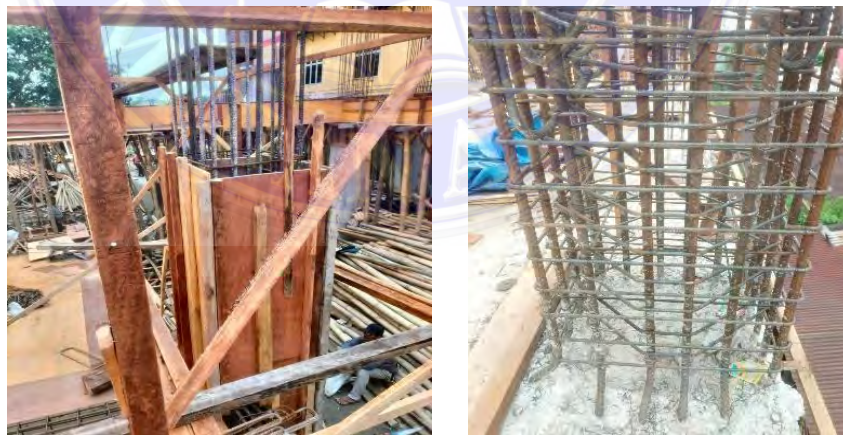
3.21 Pemasangan bekisting dan Penempatan tulangan
