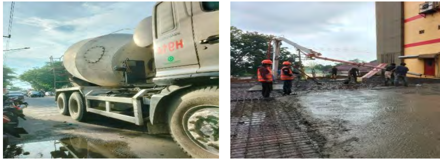
Gambar 3.22 Truk mixer dan proses pengecoran plat lantai
