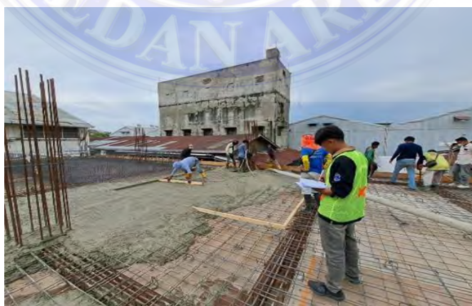
Gambar 3. 23. Pengecoran Balok
