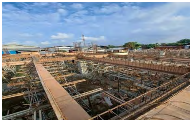
Gambar 3. 22. Penulangan Balok
