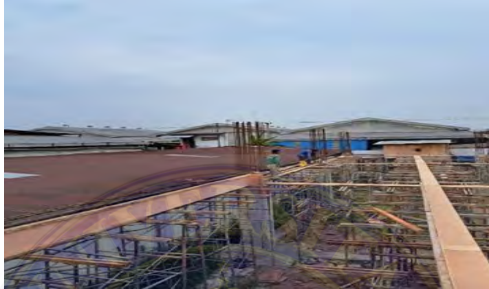
Gambar 3. 21. Perakitan tulangan balok
