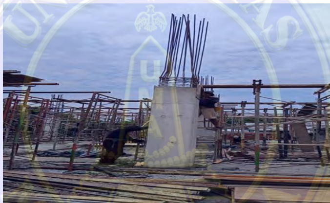
Gambar 3. 24. Pelepasan Bekisting
