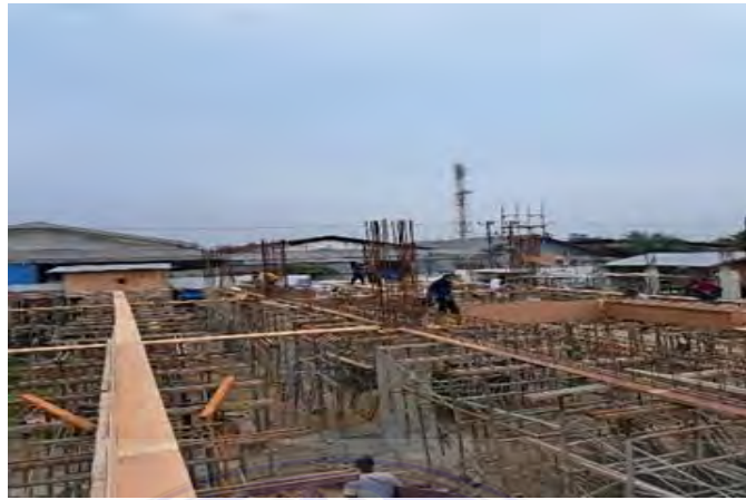
Gambar 3. 20. Perakitan tulangan balok
