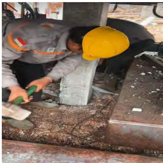
Gambar 4.6 Pemotongan Ujung Tiang
