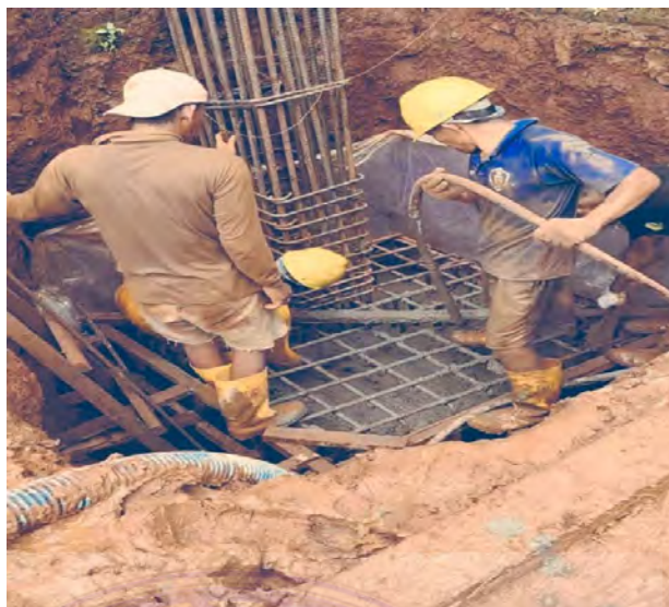
Gambar 4.5 Pembuatan Pile Cup
