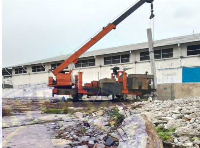
Gambar 4.1 Pengangkatan Tiang
