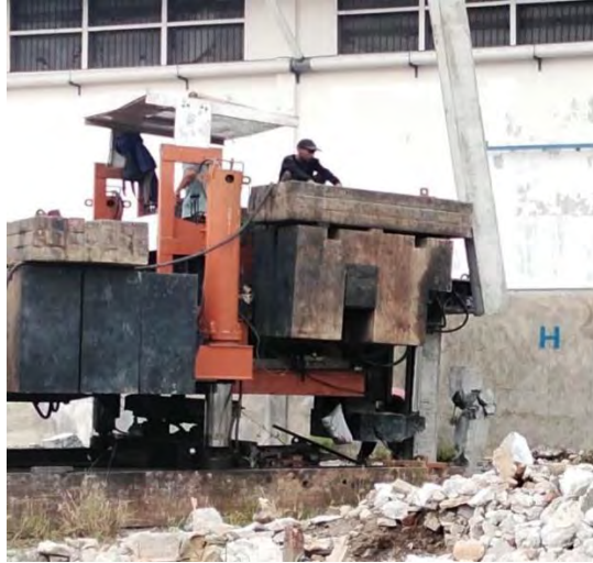
Gambar 4.2 Penyetelan dan Pemasangan Tiang
