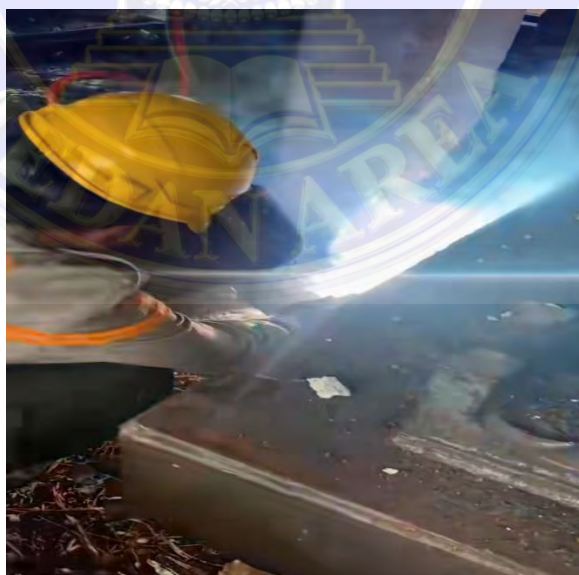
Gambar 4.4 Penyambungan Tiang
