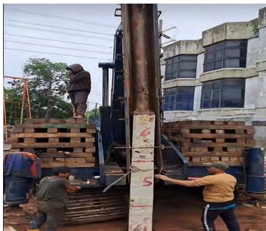
Gambar 4.3 Proses Pemancangan
