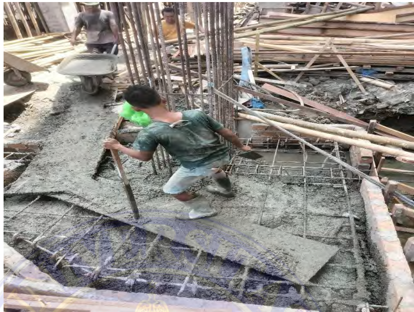
Gambar 4. 9 Pengecoran Pile Cap(Dokumentasi Proyek,2026)
