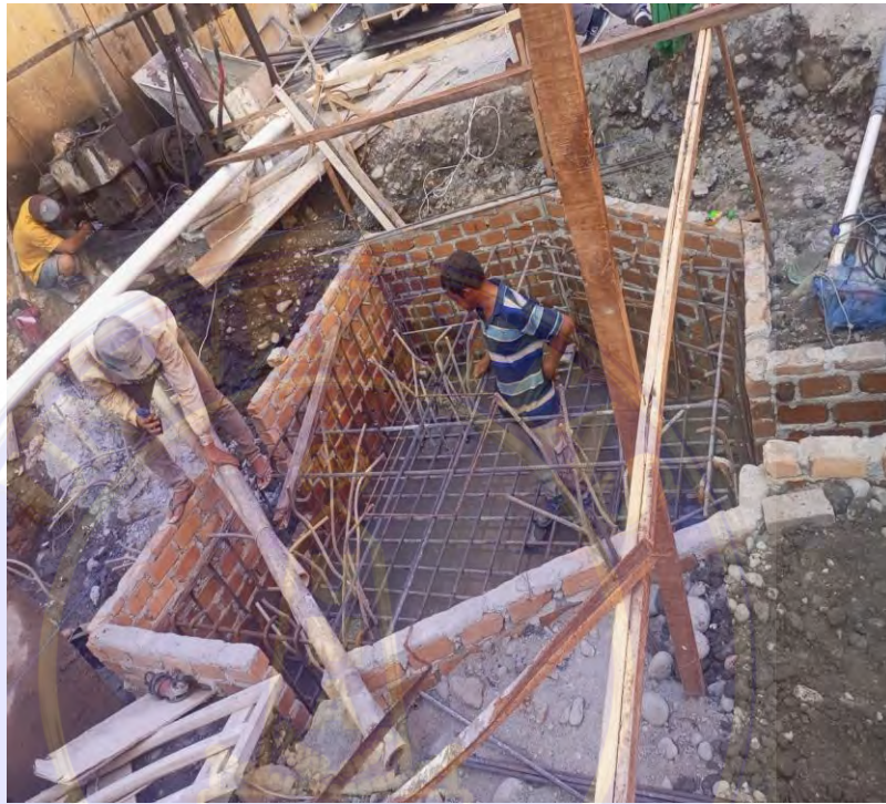
Gambar 4. 8 Pembesian Pile Cap(Dokumentasi Proyek,2026)
