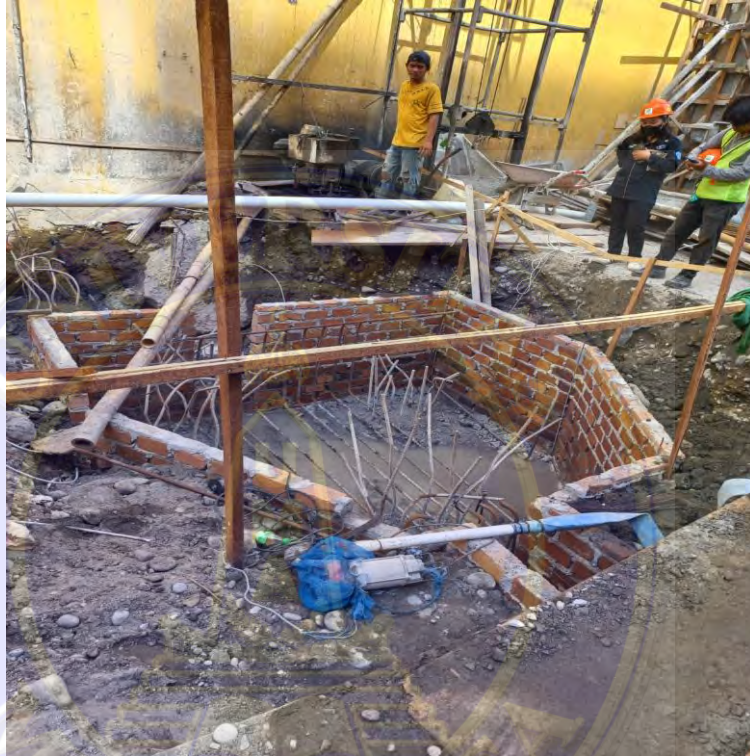
Gambar 4. 7 Pembuatan Bekisting(Dokumentasi proyek,2026)
