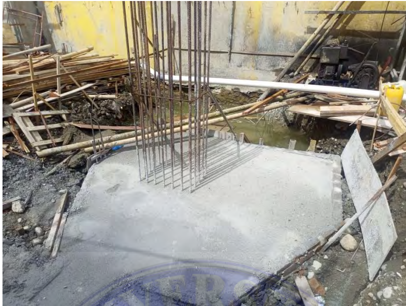
Hasil Pengecoran Pile Cap
