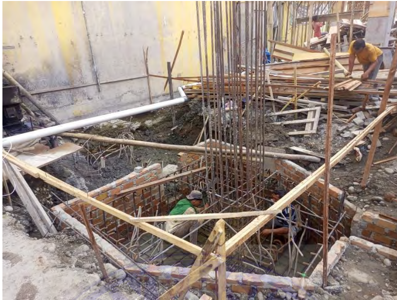
Pekerjaan Pengikatan Antara Tulangan Pile cap Dengan Kolom
