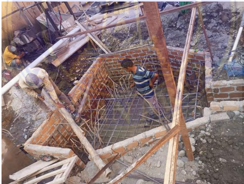
Pekerjaan Pemasangan Tulangan Pile Cap
