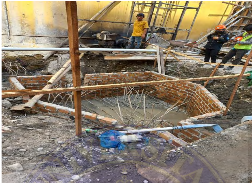
Pekerjaan Pemasangan Bekisting Pile Cap
