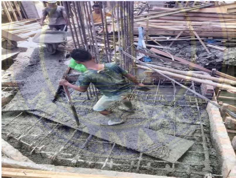
Pekerjaan Pengecoran Pile Cap
