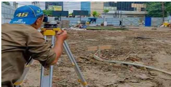
Gambar 4. 5 Penentuan titik(Dokumentasi proyek,2026)
