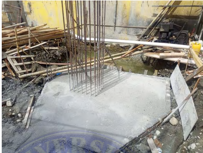
Gambar 4. 10 Hasil Pengecoran Pile Cap(Dokumentasi Proyek,2026)
