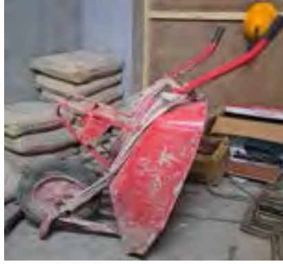
Gambar 3.7 Kereta Sorong (Dokumentasi Proyek, 2026)
