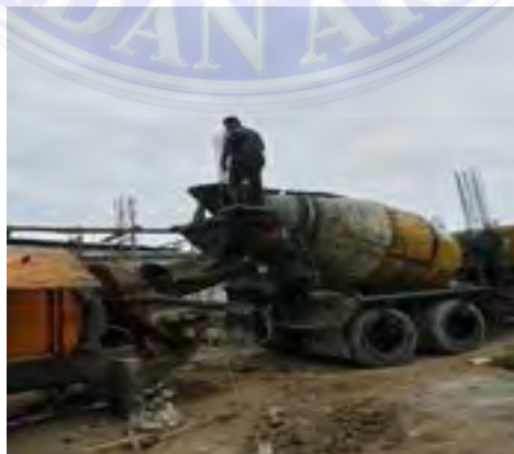
Gambar 3.2 Truck Mixer (Dokumentasi Proyek, 2026)
