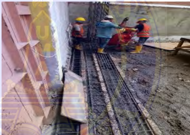
Gambar 4.4 Pengecoran balok sloof (Dokumentasi Proyek, 2026)
