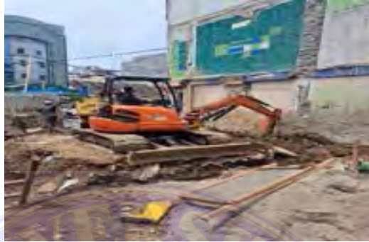
Gambar 3.1 Excavator (Dokumentasi Proyek, 2026)
