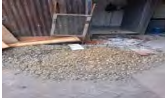
Gambar 3.14 Agregat Kasar (Dokumentasi Proyek, 2026)
