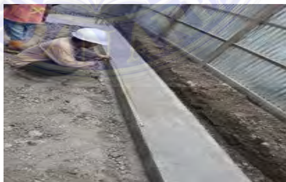
Gambar 4.5 Pngamatan akhir balok sloof (Dokumentasi Proyek, 2026)
