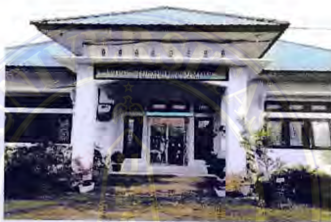
Gambar 2.1 Gedung Utama UPT. Benih Induk Hortikultura Kutagadung - Berastagi
