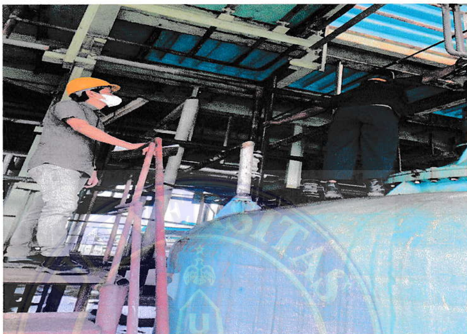
Gambar lampiran 2.1 Pengecekan Pompa di Plant Acid
