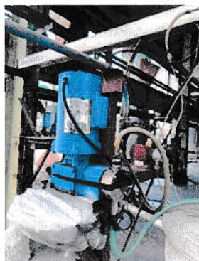
Gambar 3. 4. Pompa Torak
