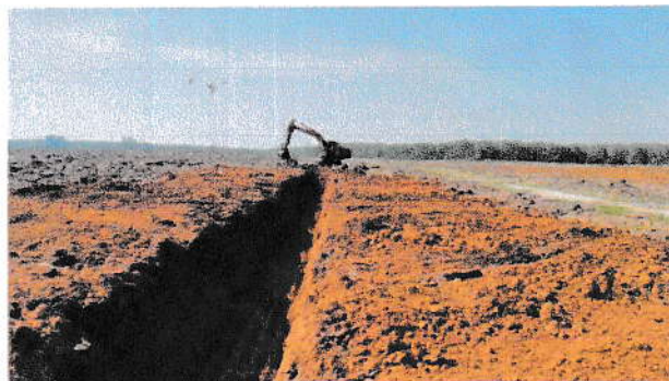
Gambar 2. Pembuatan Drainase
