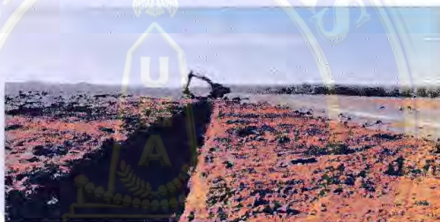
Gambar 2. Pembuatan Drainase
