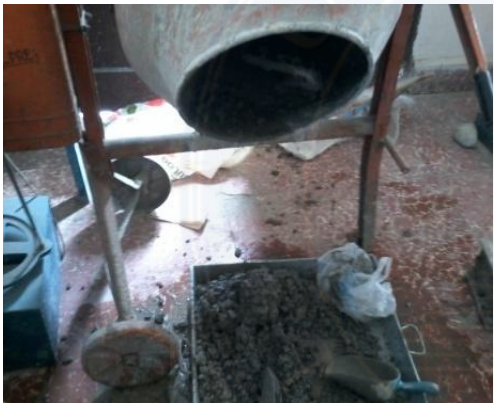
Pengadukan Beton Segar
