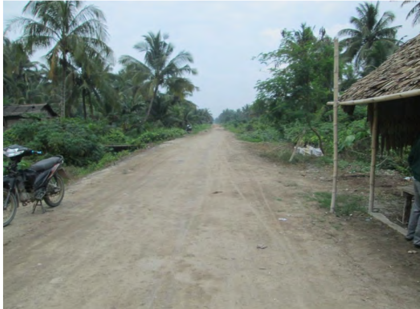
GAMBAR : KONDISI JALAN DI LOKASI PENELITIAN
