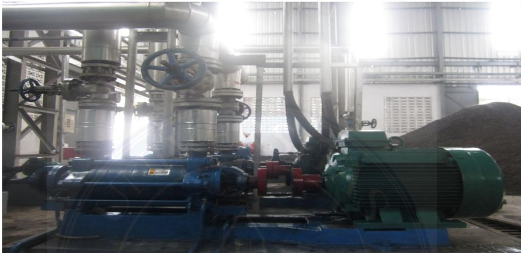
Gambar 3.1 Pompa Sentrifugal Bertingkat yang digerakkan oleh motor listrik.
