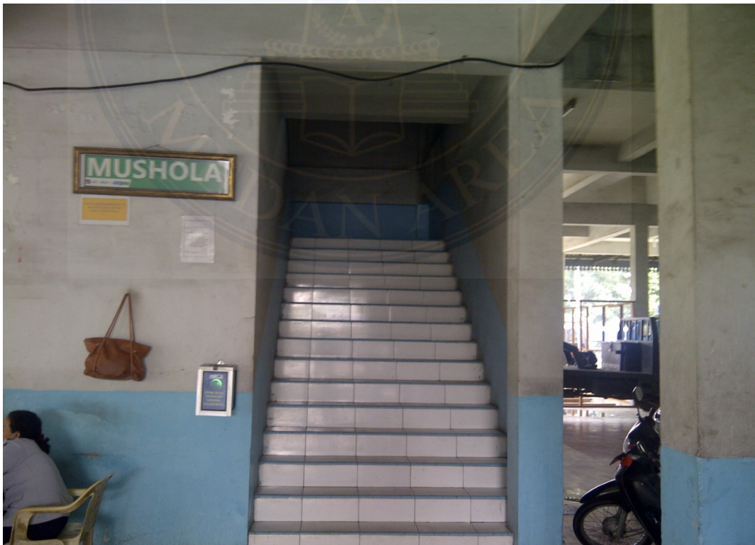
Gambar Tangga Menuju Mushollah dan Ruang Tower Pengawasan
