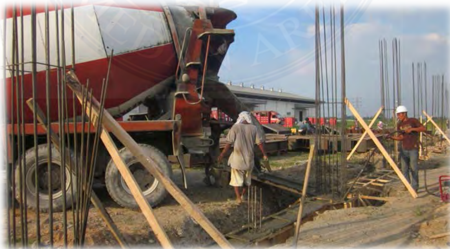
Bekisting PR1, PR2, SF1, dan pembesian Kolom K1
