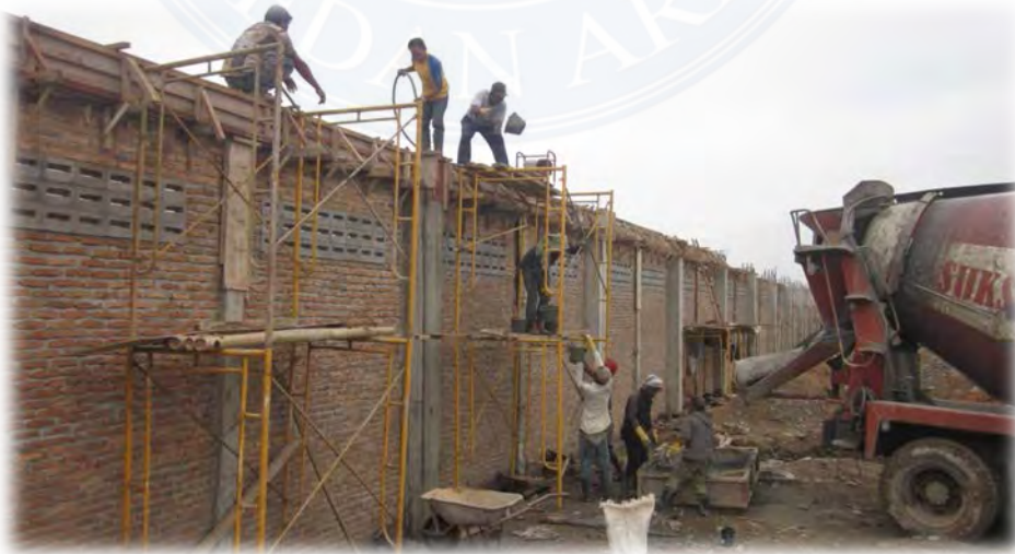
Pemasangan Bekisting, Pembesian, dan Pengecoran Balok BL1
