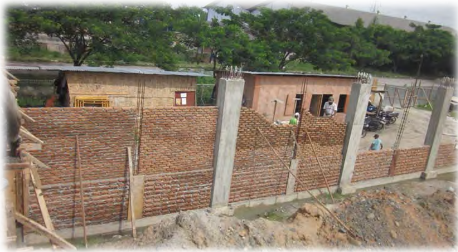
Pemasangan Dinding Batu Bata
