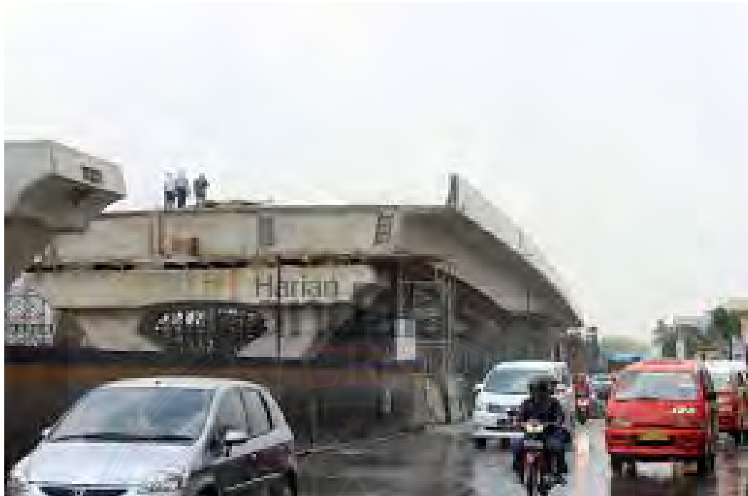
Gambar penampang box girder setelah selesai stressing dan grouting
