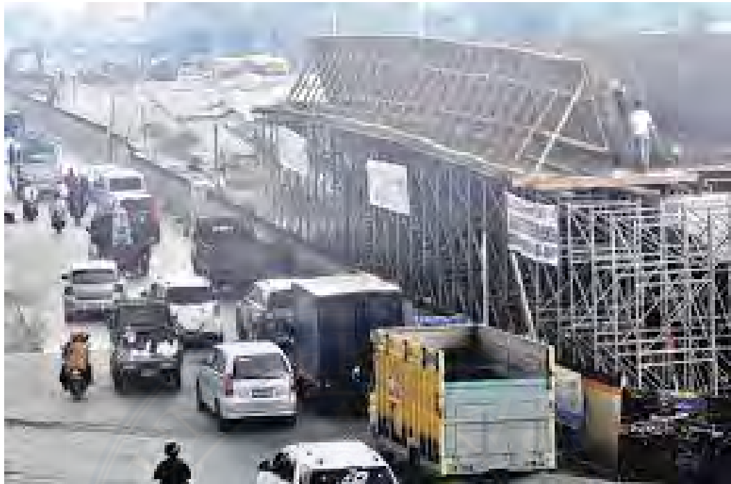
Gambar pembuatan bekisting Box girder pada bentang tengah
