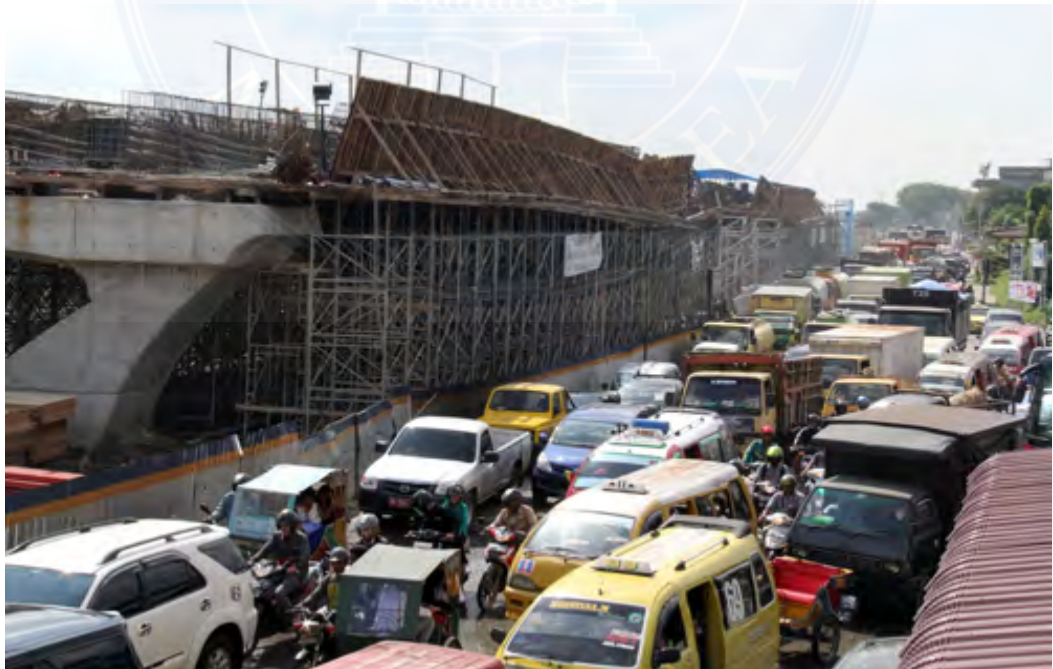
Gambar pembuatan bekisting Box girder pada bentang tengah
