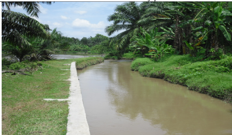
Saluran induk Bajayu, air masuk dari free intake
