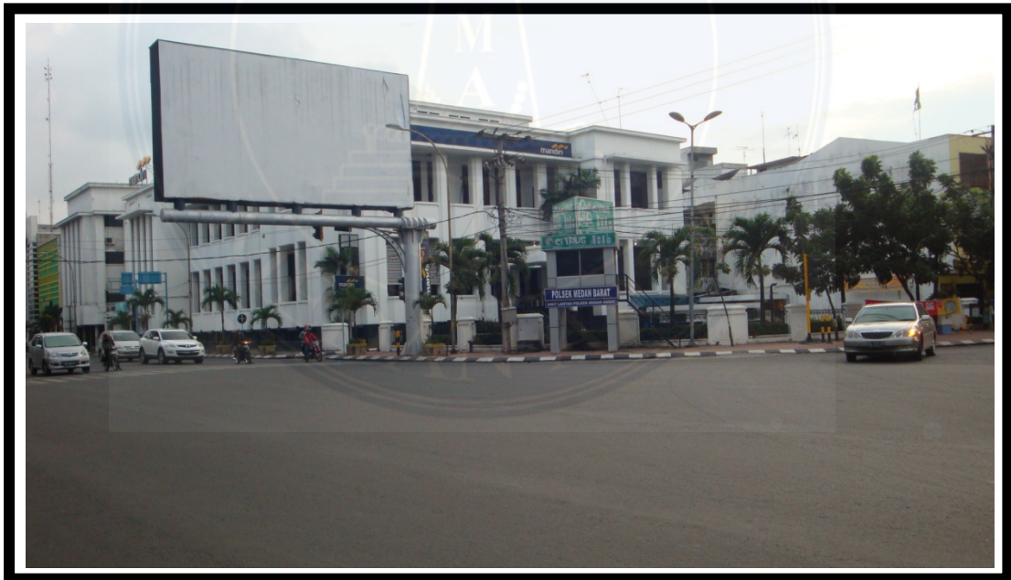
Gambar 14 : Persimpangan Jalan Raden Saleh dan Jalan Balai Kota.
