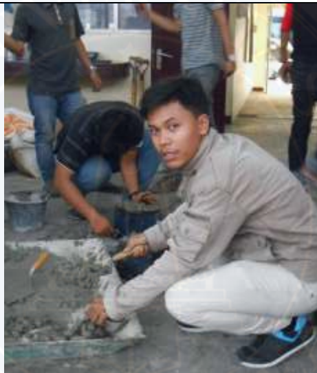
Penuangan campuran beton ke wadah
