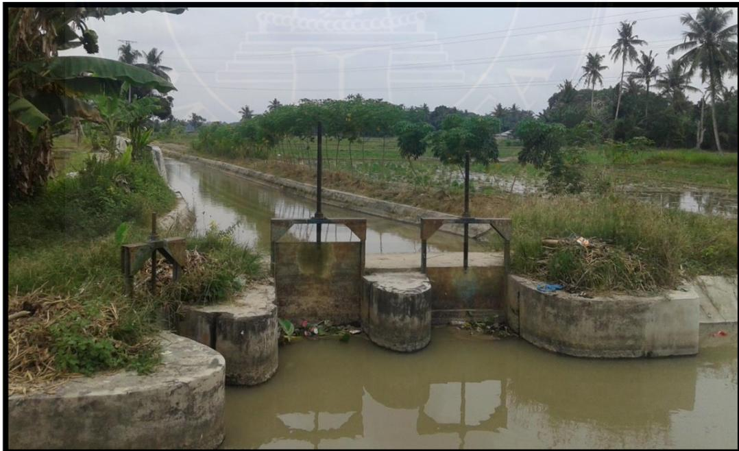
Gambar 3. Bangunan bagi dari saluran primer menuju saluran sekunder
