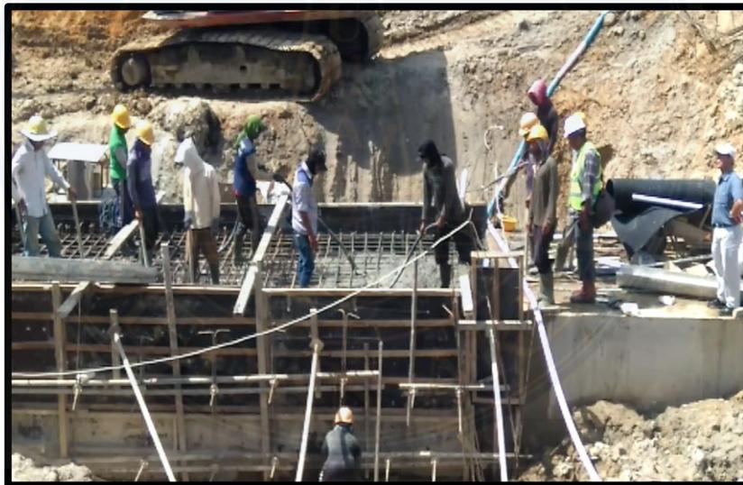
Gambar: Pemasangan Adukan Beton Dengan Vibrator
