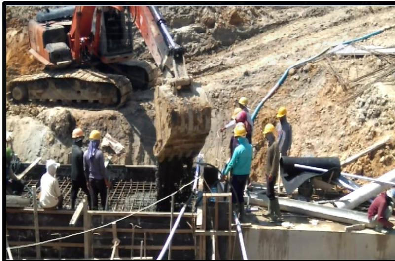
Gambar: Pengecoran Plat Atas Siphon
