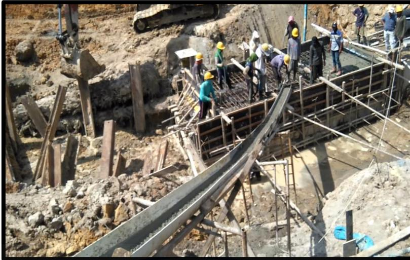
Gambar: Pengecoran Plat Atas Siphon Menggunakan Pipa Bantuan
