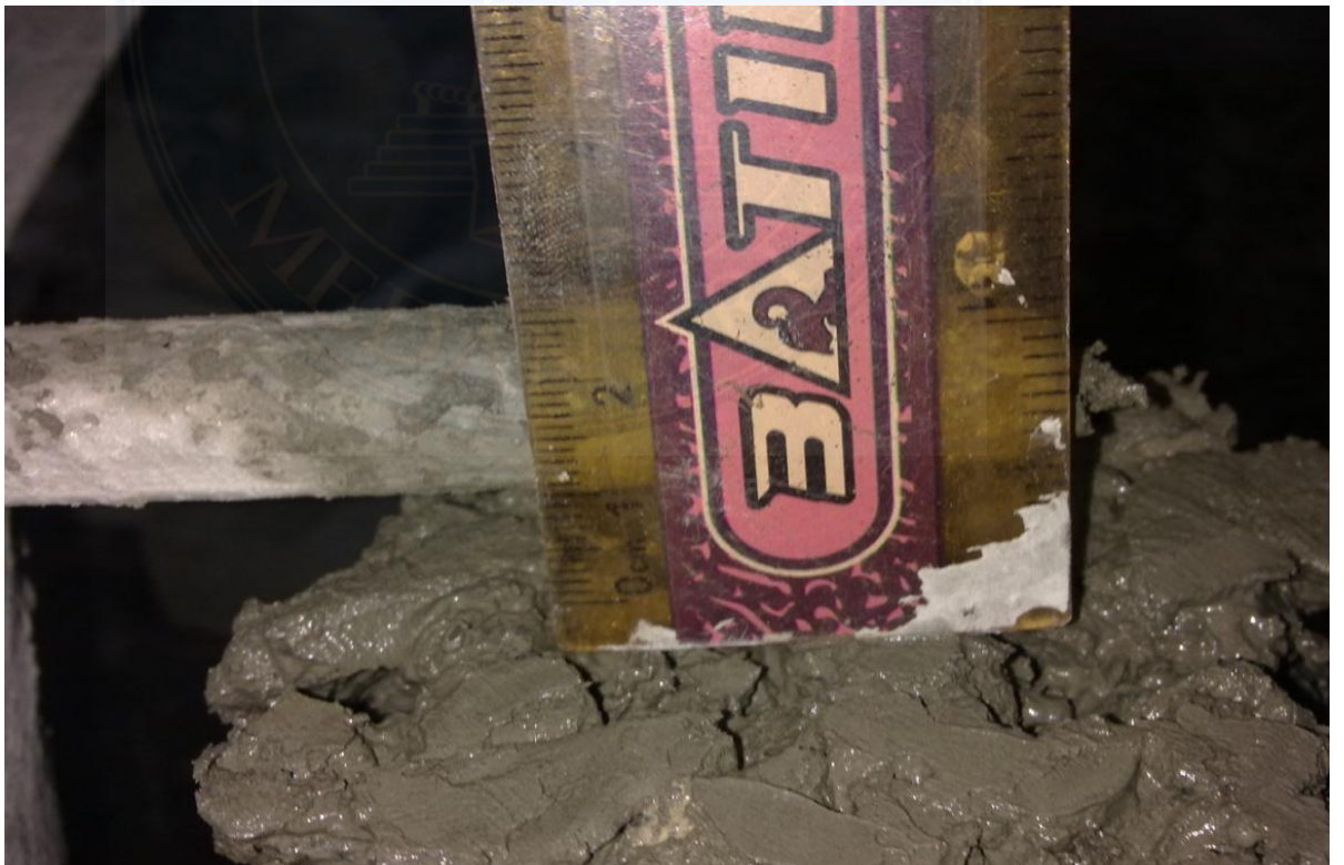
Pengukuran nilai slump
