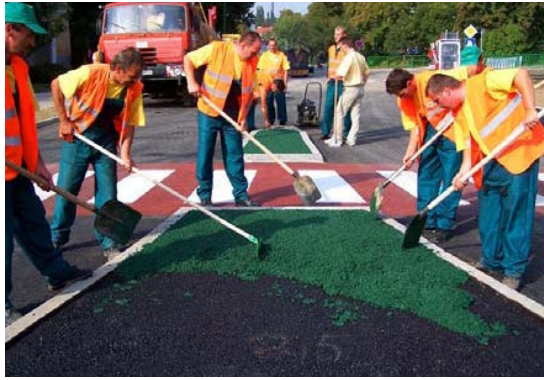
(a) Konstruksi perkerasan lentur menggunakan bioasphalt vegecol™ aspal hayati
