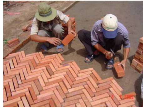
(b) Konstruksi perkerasan modular menggunakan batu bata dari abu sekam padi
