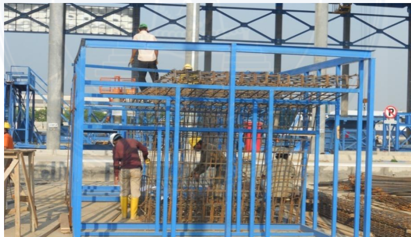
Gambar 3.3 Rakitan Tulangan Box Girder Pada Rebar Cage
