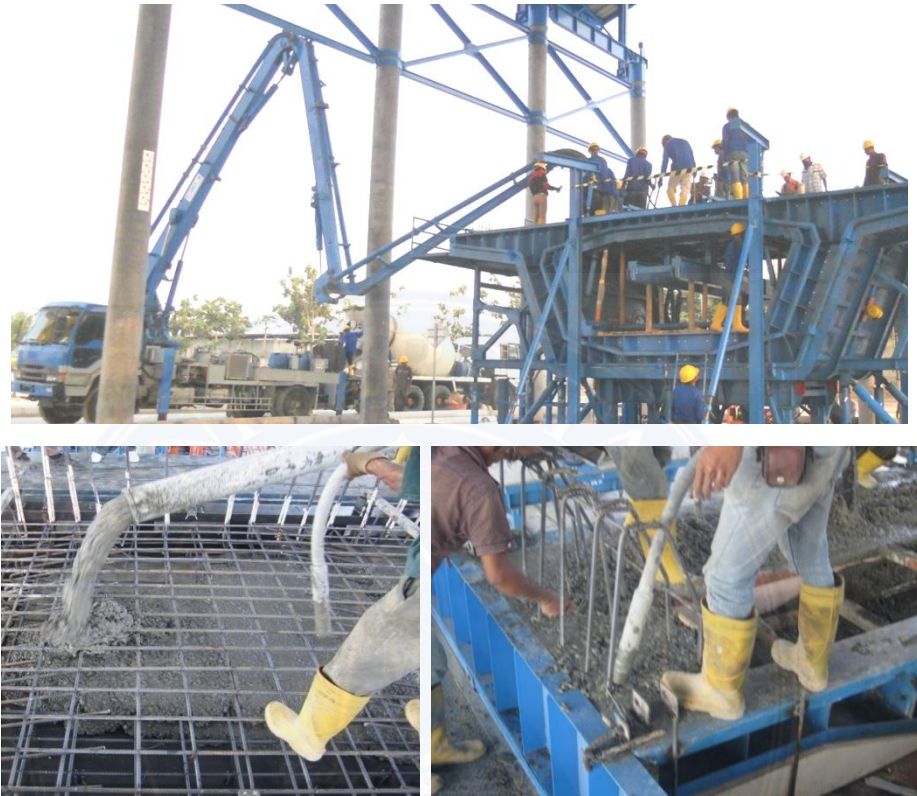
Gambar 3.6 Pekerjaan Pengecoran Segmen Box Girder
