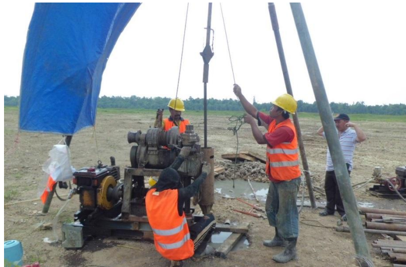
Gambar 2.6 Sumber Air Dari Sumur Bor Untuk Pengadukan Beton
