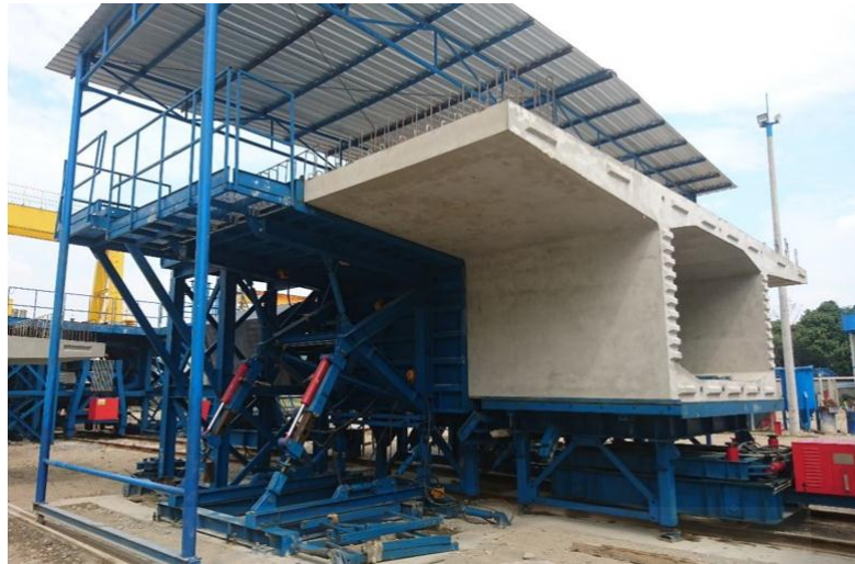
Proses Buka Produk Segmen Box Girder Dari Cetakan
