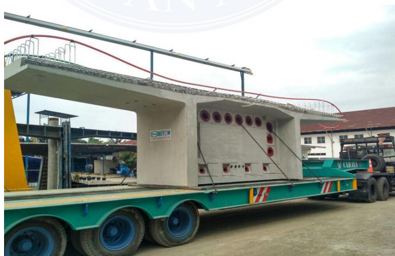
Pengangkutan Segmen Box Girder Dari Pabrik Ke Lokasi Proyek
