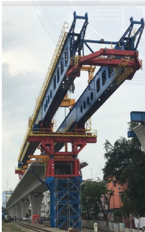
Pekerjaan Instalasi Segmen Box Girder Dengan Launching Gantry
