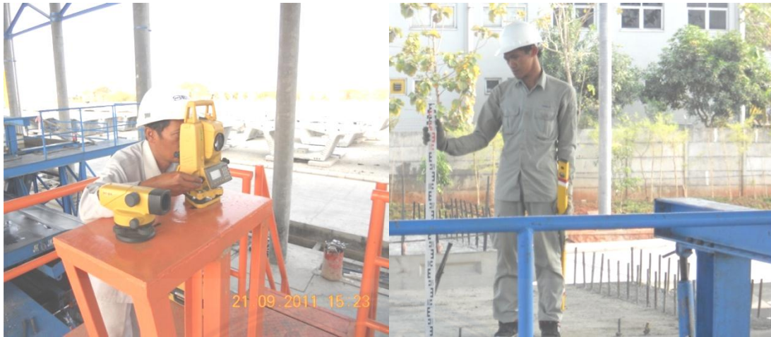
Gambar 3.4 Setting Ketegakkan Cetakan Box Girder Oleh Surveyor
