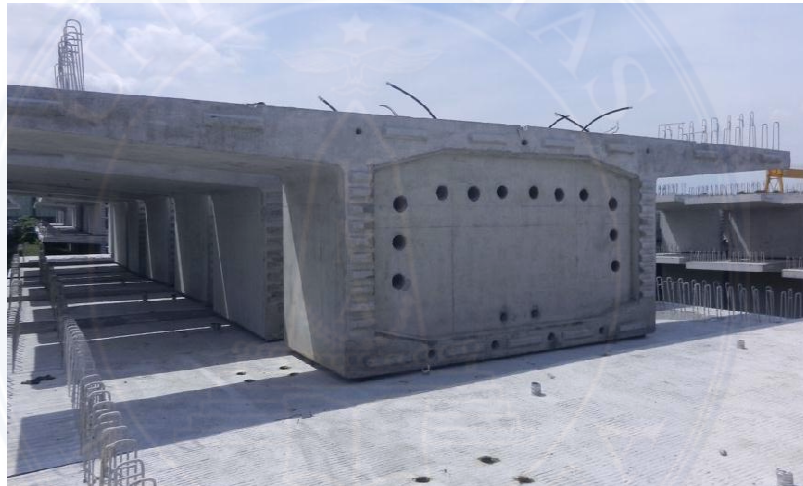
Penumpukkan Segmen Box Girder Di Stock Yard Sesuai Dengan Tipenya
