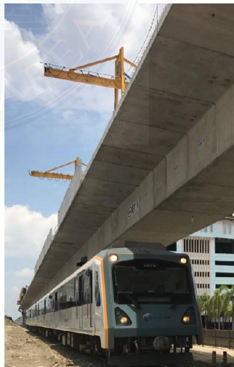
Pemasangan Barrier Pada Tepi Atas Box Girder
