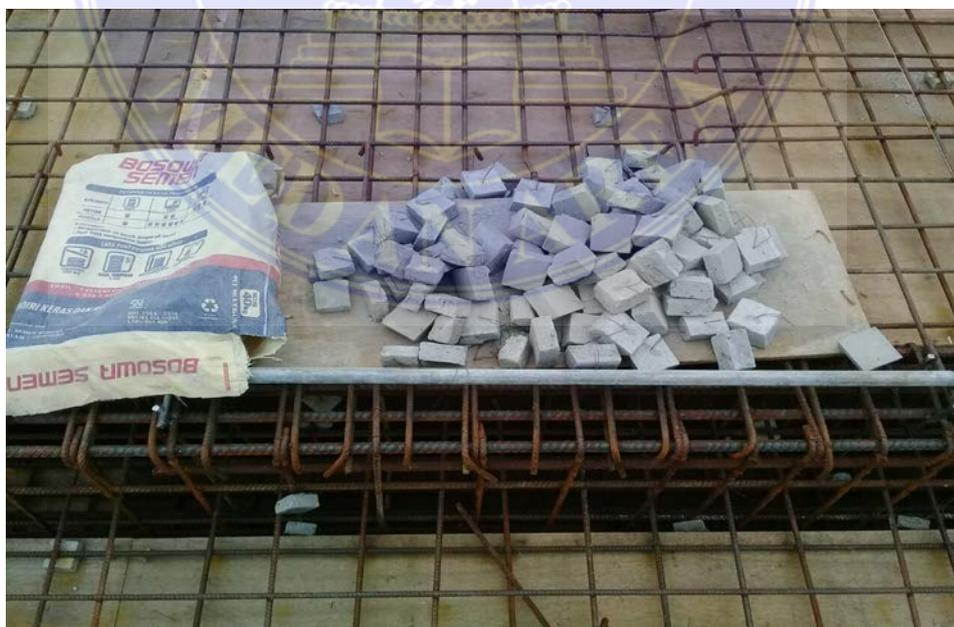
Gambar 6. Decking sebagai pembatas selimut beton
