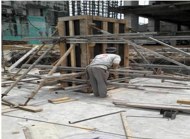
Gambar 2.8 : Bekisting Kolom
