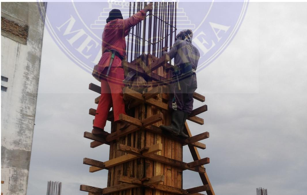
Gambar 22. Pembongkaran bekisting
