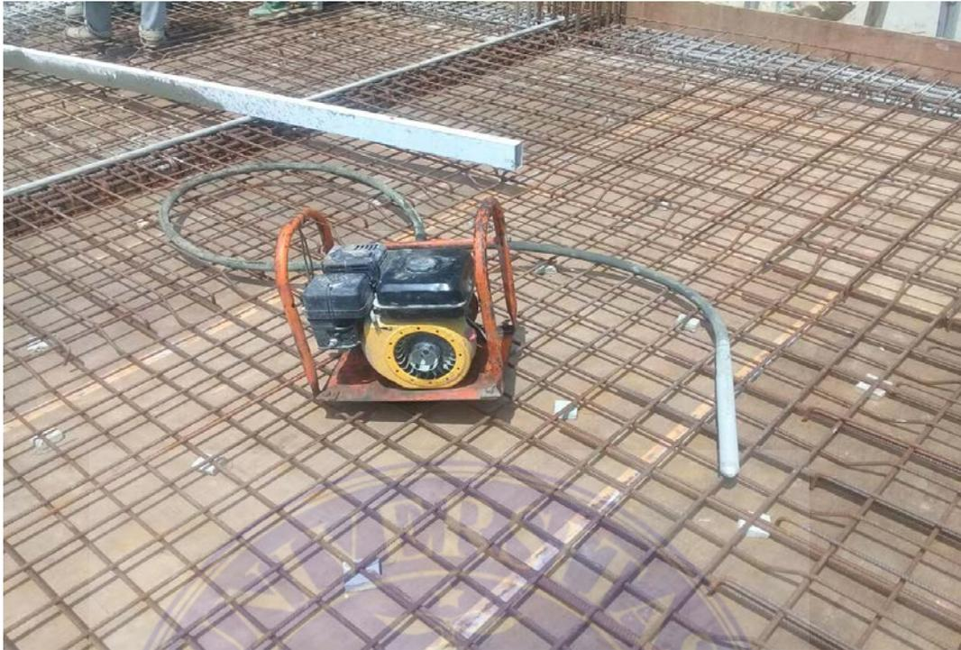
Gambar 19. Mesin vibrator sebagai alat pemadat beton
