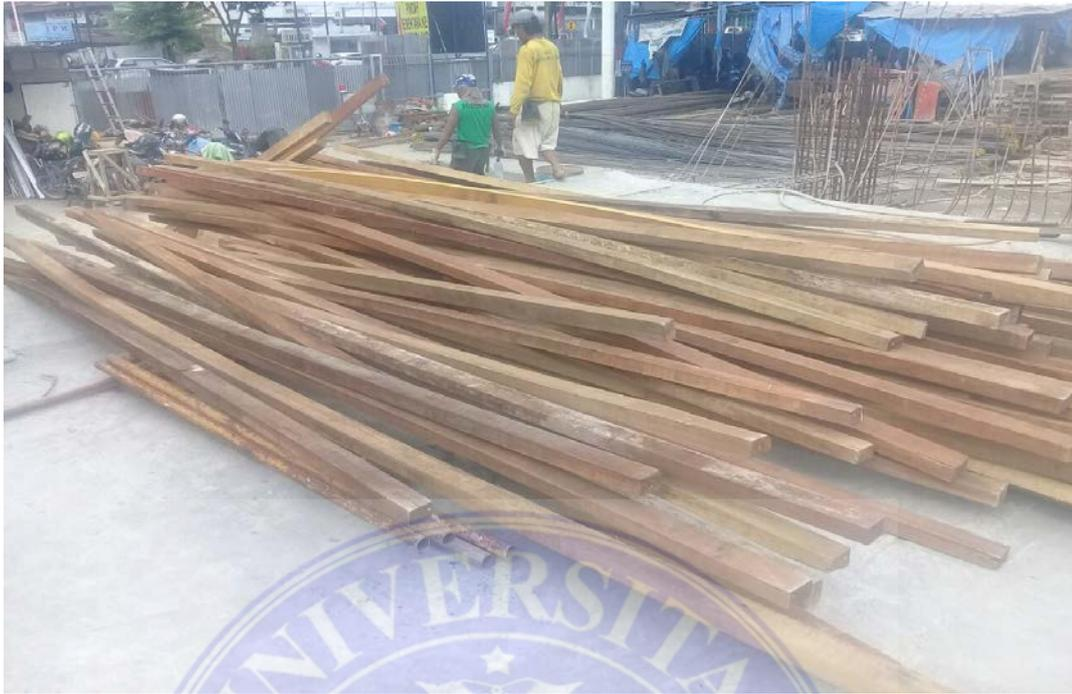
Gambar 3. Kayu broti berfungsi sebagai balok stang / selendang bekisting kolom,
